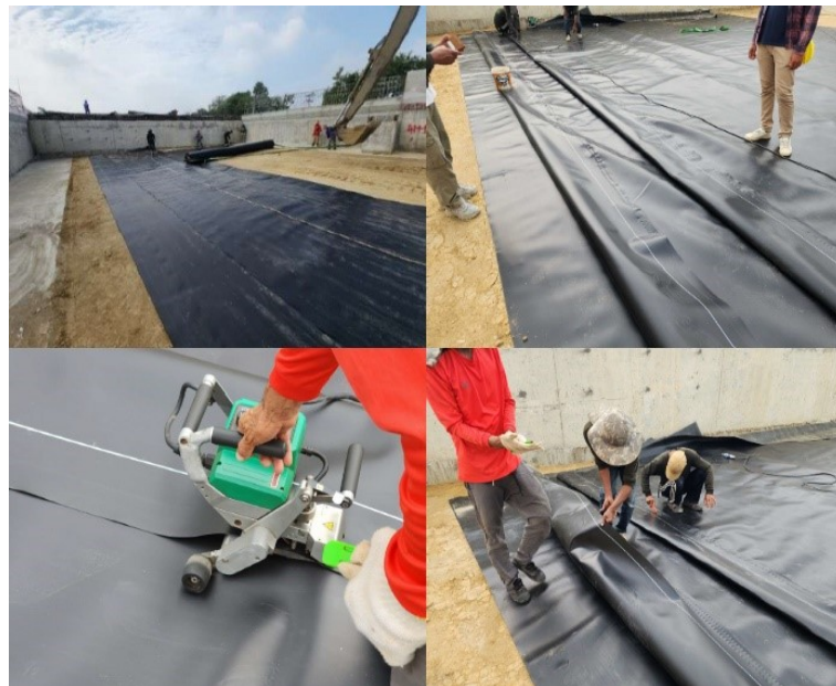
ภาพที่ 9 การจัดวางและการเชื่อมแผ่น Geomembrane
