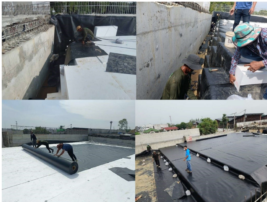
ภาพที่ 17 การปิดทับบล็อก EPS Foam ด้วยแผ่นพลาสติก Geomembrane
