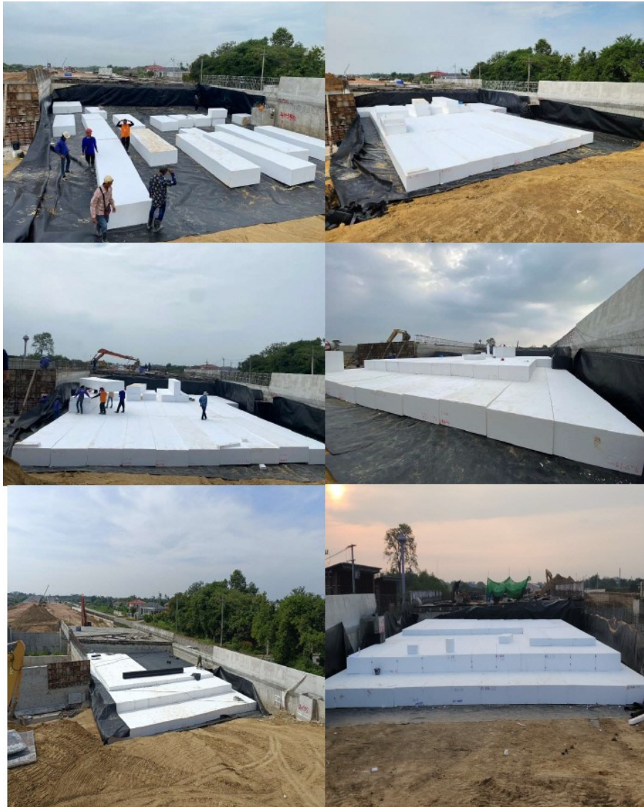
ภาพที่ 14 การจัดวางบล็อก EPS Foam ในพื้นที่ก่อสร้าง
