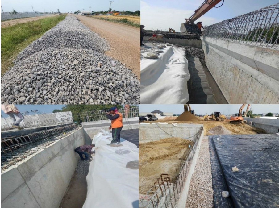
ภาพที่ 18 ลงวัสดุ Fill Gap with Granular Material
