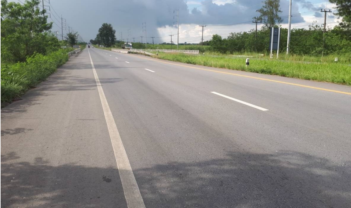
ภาพที่ 3.3 รูปภายหลังการบูรณะทางหลวงหมายเลข 344 ตอน อ.บ้านบึง – อ.แกลง กม. 37+ 800 RT
