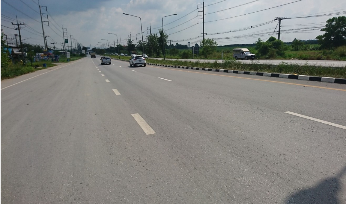
ภาพที่ 3.1 รูปถ่ายหลังการบูรณะทางหลวงหมายเลข 344 ตอน อ.บ้านบึง – อ.แกลง กม. 32+ 600 LT
