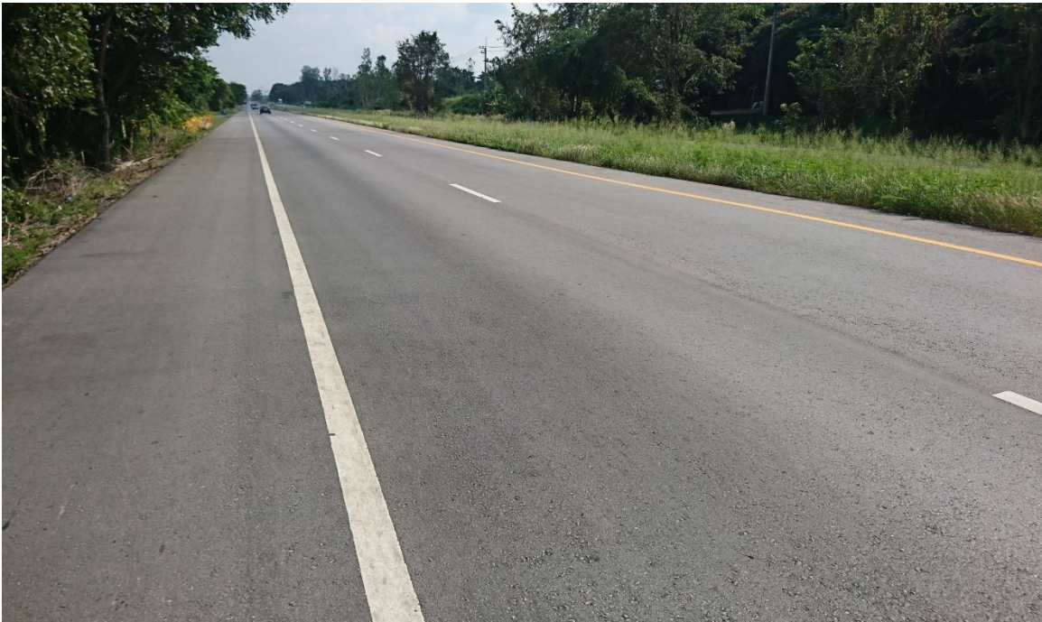
ภาพที่ 3.2 รูปถ่ายหลังการบูรณะทางหลวงหมายเลข 344 ตอน อ.บ้านบึง – อ.แกลง กม. 55+ 000 LT
