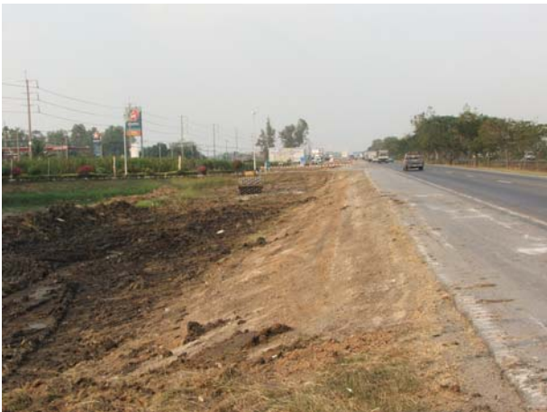
งานบดอัดดินเดิม Foundation Compact
