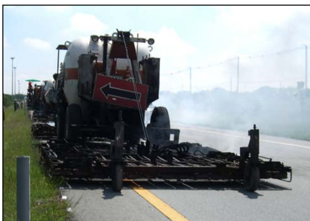
เครื่องจักร In-Place Recycling
