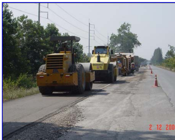
การปู บดอัด และการปรับระดับ งาน Recycling
