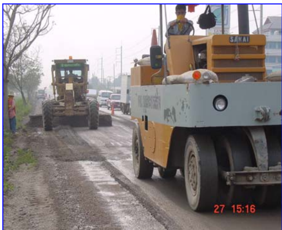
การปู บดอัด และการปรับระดับ งาน Recycling
