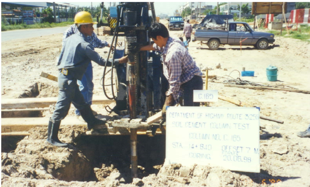
ภาพแสดงการ Coring Cement Column เก็บตัวอย่างไปทดสอบในห้องทดลอง
