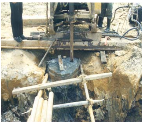
ภาพแสดง การเจาะริม Column 4 รู ตลอดความลึก
