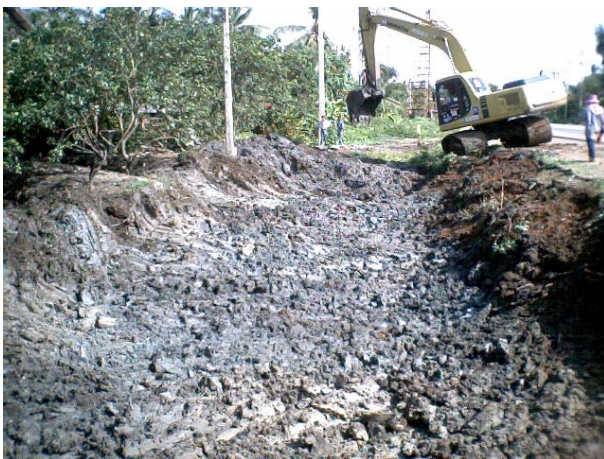
งานขุดวัสดุไม่เหมาะสม
