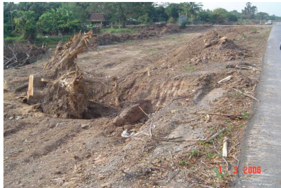
งาน Clearing & Grubbing
