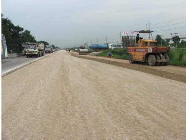
งานพื้นทางหินคลุก
