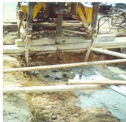
ภาพแสดง การเจาะริม Column 4 รู ตลอดความลึก
