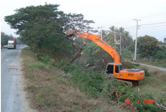
งาน Clearing & Grubbing
