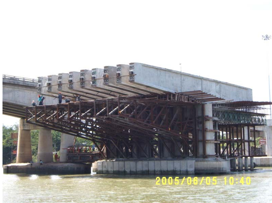
รูปที่ ข.9 แบบหล่อสะพานยื่น
