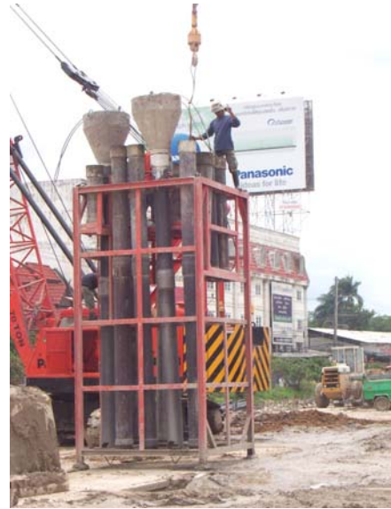
รูปที่ 5.9 แบบหล่อปิดปลายผนังพีต (Stop End Plates) รูปที่ 5.10 ท่อสำหรับเทคอนกรีต (Tremie Pipe)
