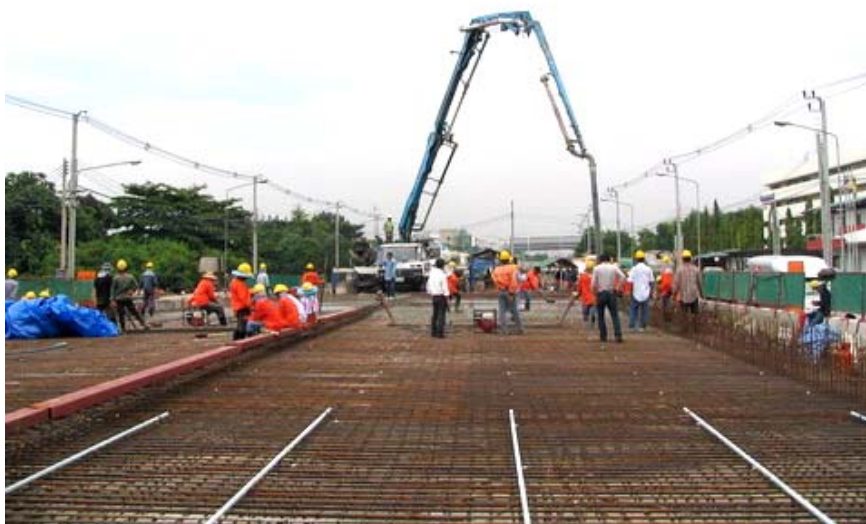
รูปที่ ค.6 การลำเลียงคอนกรีตโดยใช้คอนกรีตปั๊ม
