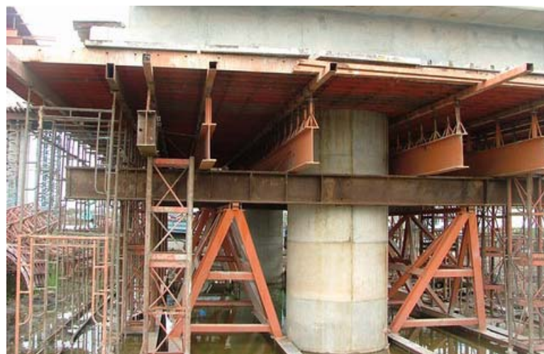
รูปที่ ข.6 การติดตั้งคานรองรับ และตงรับท้องแบบพื้นสะพาน
