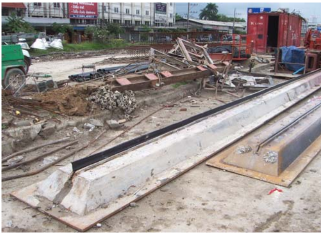
รูปที่ 5.9 แบบหล่อปิดปลายผนังพีต (Stop End Plates) รูปที่ 5.10 ท่อสำหรับเทคอนกรีต (Tremie Pipe)
