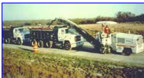
รูปที่ 10.4 การรื้อหรือตัดชั้นทางแอสฟัลต์คอนกรีตเดิม และการย่อยแล้วนำไป Stock Pile
