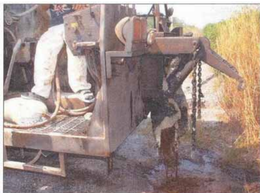
รูปที่ 1 เครื่องจักรงาน Slurry Seal ขณะปรับเทียบแอสฟัลต์
