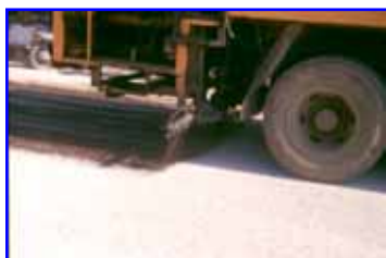
รูปที่ 9.2 การก่อสร้างผิวทางแบบเคพซีล
