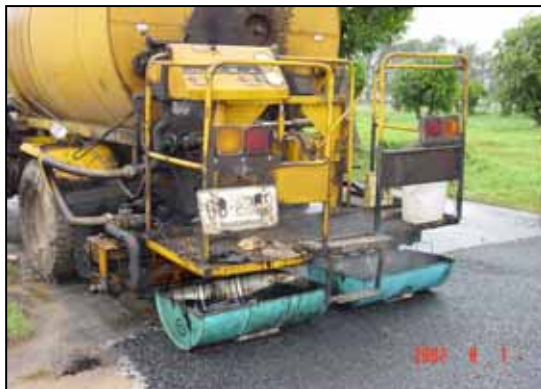
รูปที่ 5 แสดงการสอบเทียบอัตราการไหลของยางแอสฟัลต์
