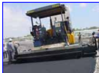
รูปที่ 27 การปูและตรวจวัดอุณหภูมิ
