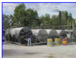
รูปที่ 20 การเตรียมแอสฟัลต์
