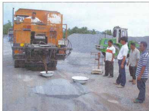
รูปที่ 1 เครื่องจักรงาน Slurry Seal ขณะปรับเทียบแอสฟัลต์
