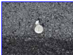
รูปที่ 27 การปูและตรวจวัดอุณหภูมิ
