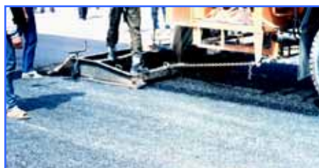
รูปที่ 9.2 การก่อสร้างผิวทางแบบเคพซีล
