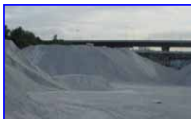
รูปที่ 17 สถานที่ตั้งโรงงานผสมต้องเหมาะสม การกองวัสดุต้องถูกต้อง
