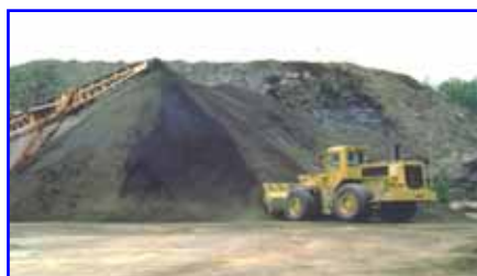
รูปที่ 10.4 การรื้อหรือตัดชั้นทางแอสฟัลต์คอนกรีตเดิม และการย่อยแล้วนำไป Stock Pile
