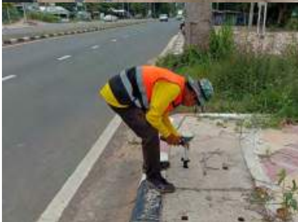
รูปที่ 4.3-2 การสำรวจระบบระบายน้ำแบบตามยาว ในพื้นที่เป้าหมายที่คัดเลือก
