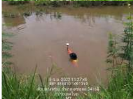
รูปที่ 6.2-2 การสำรวจจริงวัด สำหรับตำแหน่งการปรับปรุงอาคารระบายน้ำด้วยวิธี RTK
