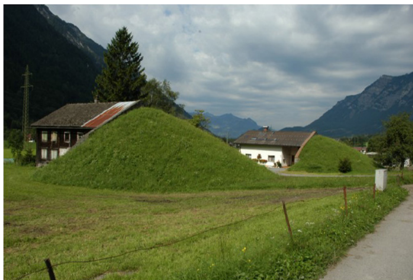
รูปที่ 19 โครงสร้างเบี่ยงทิศทาง การไหลของดินโคลนถล่ม
