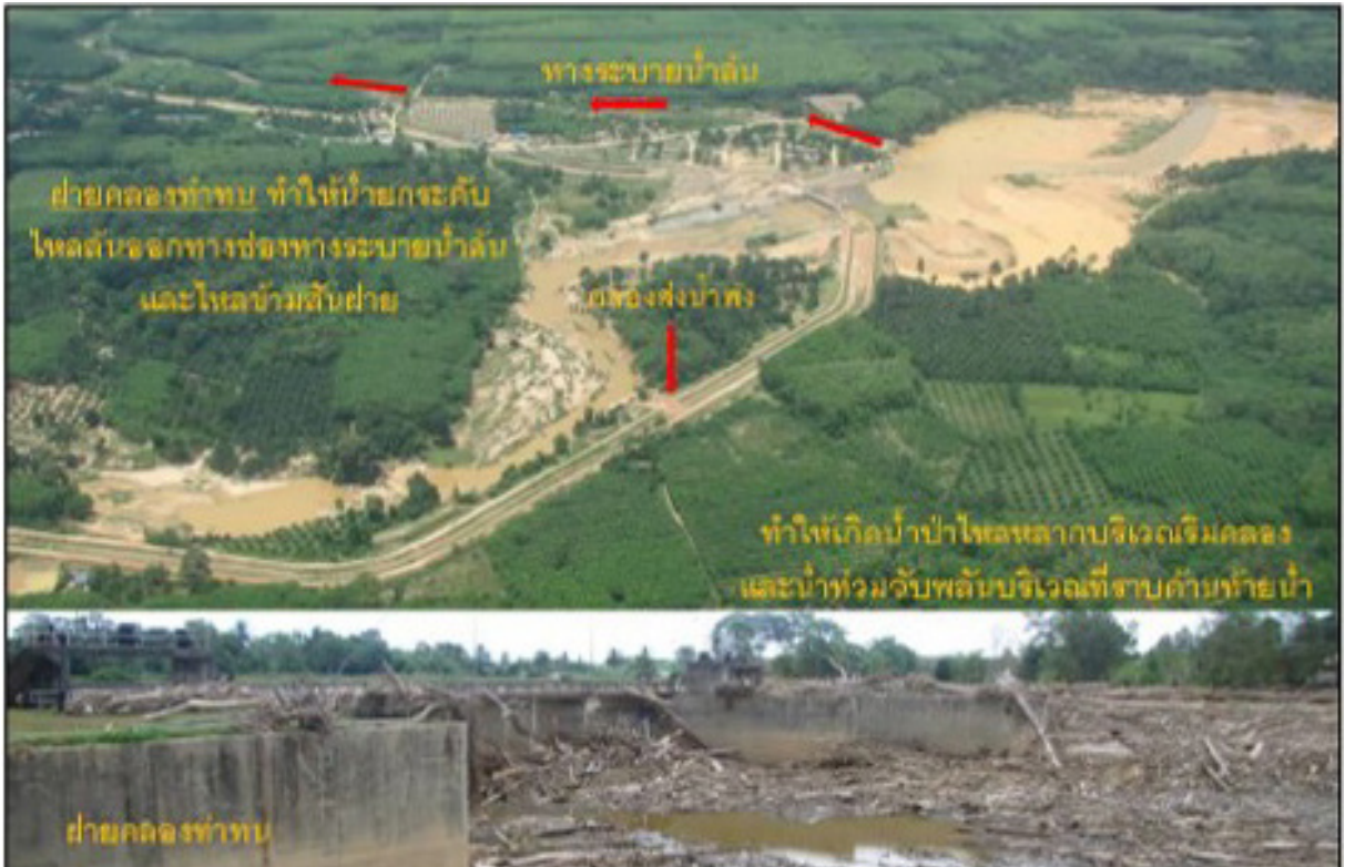
รูปผนวกที่ 2 ฝายคลองท่าทาบที่สร้างกีดขวางทางน้ำ ทำให้กระต๊อบน้ำท่วมเป็นบริเวณกว้าง
