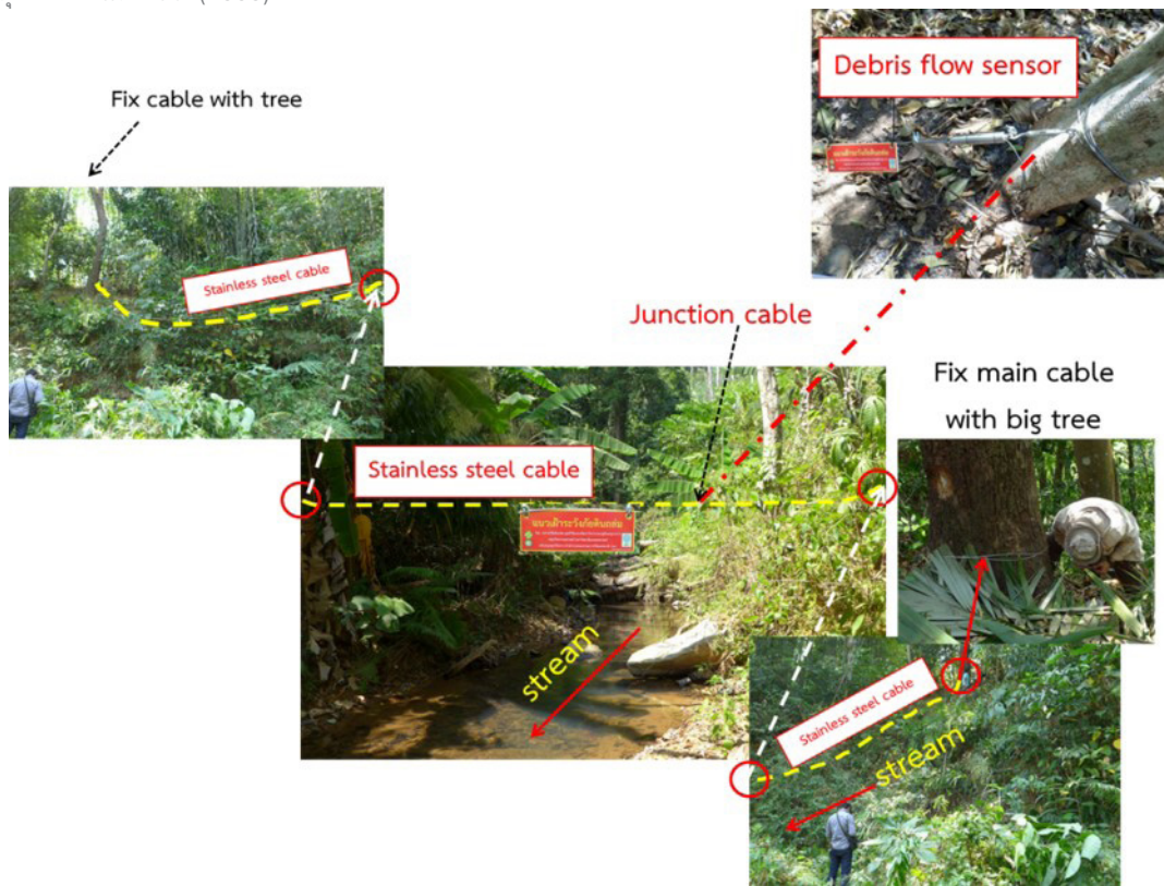
รูปที่ 28 ตัวอย่างขั้นตอนการติดตั้งเครื่องมือตรวจวัดการไหล (debris flow sensor) ในพื้นที่เสี่ยงภัยดินถล่มและน้ำป่าไหลหลาก
