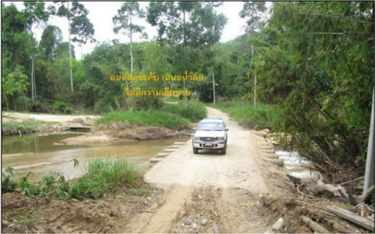
รูปผนวกที่ 4 ถนนแบบลระดับน้ำ (ถนนน้ำล้น) ซึ่งเหมาะสมกับพื้นที่ทางน้ำขนาดเล็ก
