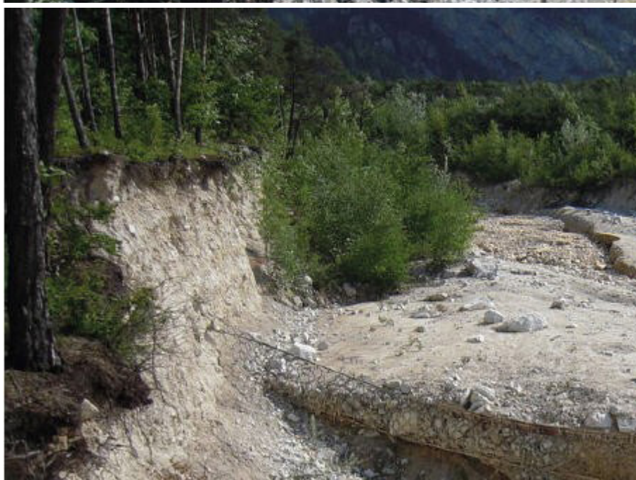
รูปที่ 18 ตัวอย่าง flexible debris flow barriers
