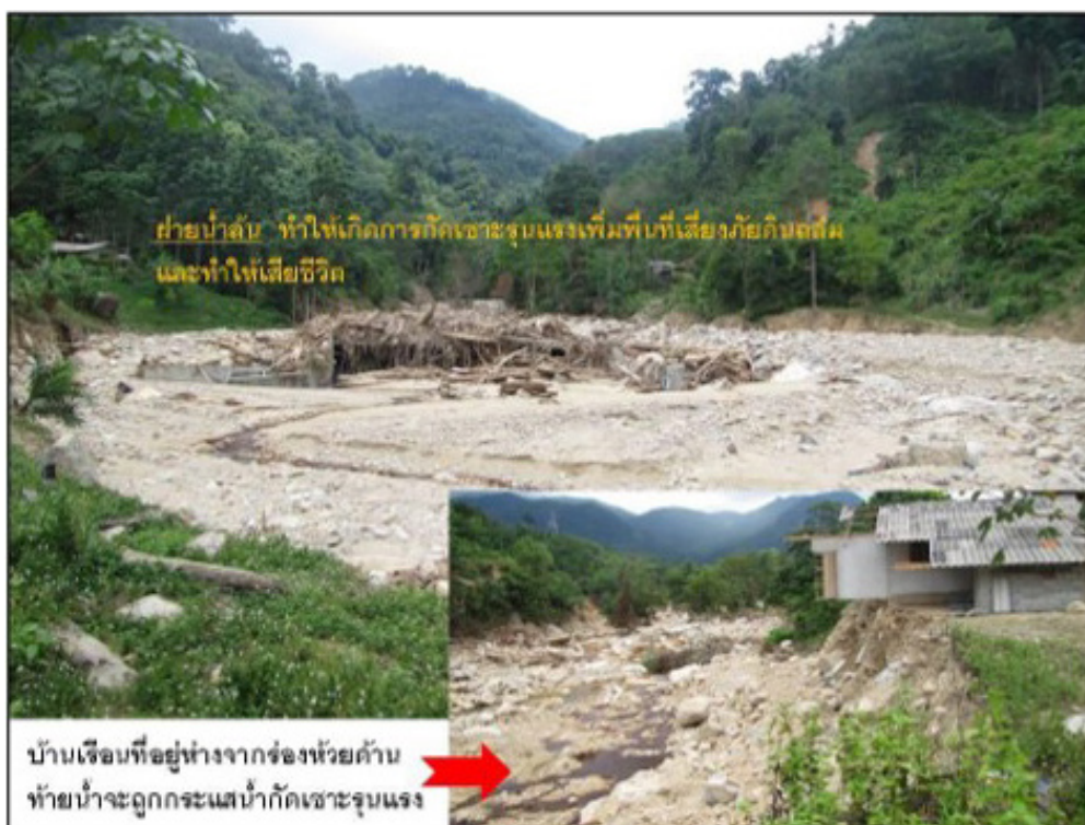
รูปผนวกที่ 1 ฝายน้ำล้นกัดขวางทางน้ำ ทำให้กัดเซาะตลิ่งและบ้านเรือนเสียหาย
