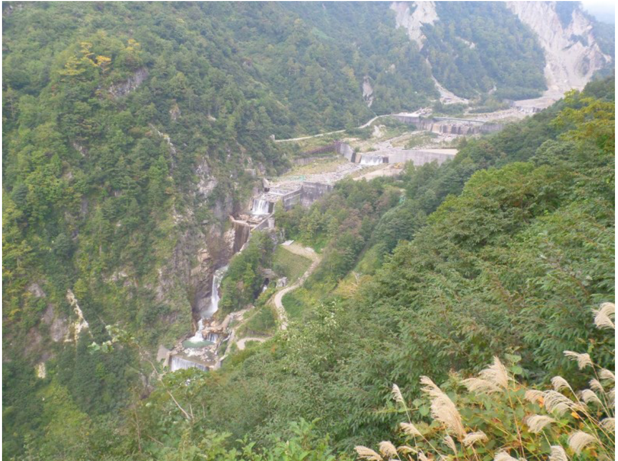
รูปที่ 12 โครงสร้างเขื่อนดักตะกอน (check dam)
