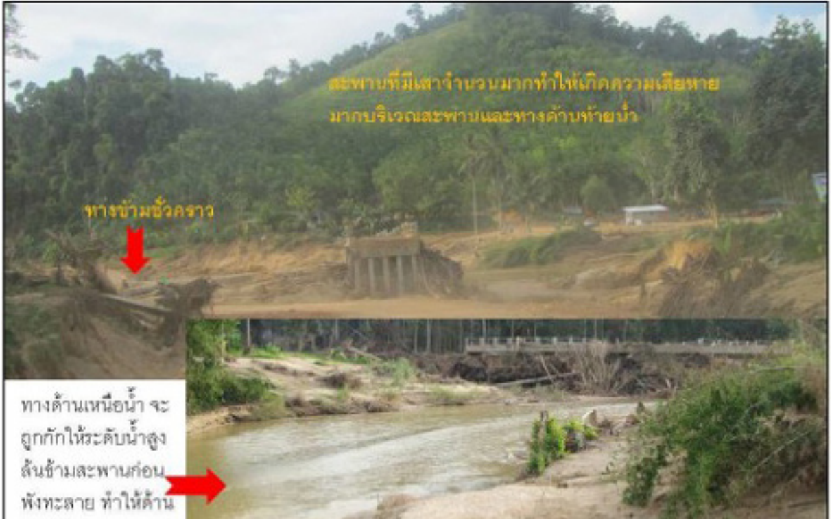
รูปผนวกที่ 3 สะพานข้ามลำน้ำซึ่งมีเสาสะพานจำนวนมาก กลายเป็นเขื่อนขนาดย่อมกีดขวางการไหลของเศษซากไม้และตะกอนดิน เมื่อไม่สามารถต้านทานไหวจึงพังทลาย
