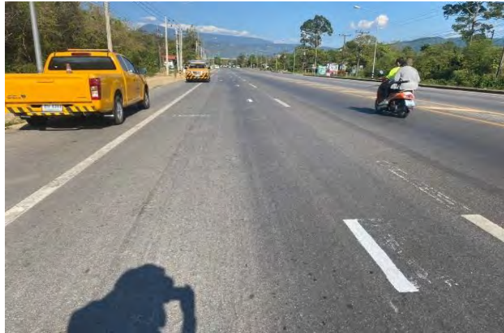
รูปที่ 1-45 พื้นที่ทดสอบอุปกรณ์ ทางหลวงหมายเลข 3049 ตอน 100 ผิวทางลาดยาง มีการกำหนดเส้นเล็งแนว เพื่อให้รถสำรวจที่ทำการทดสอบ วิ่งไปในแนวเดียวกัน
