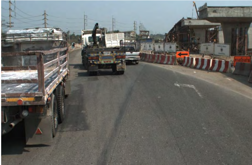
รูปที่ 2-1 อุปสรรคงานก่อสร้างสะพานระหว่างการสำรวจ
