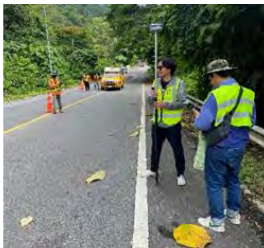
รูปที่ 1-160 การเก็บค่าพิกัดด้วยอุปกรณ์รับสัญญาณ GNSS แบบ RTK
