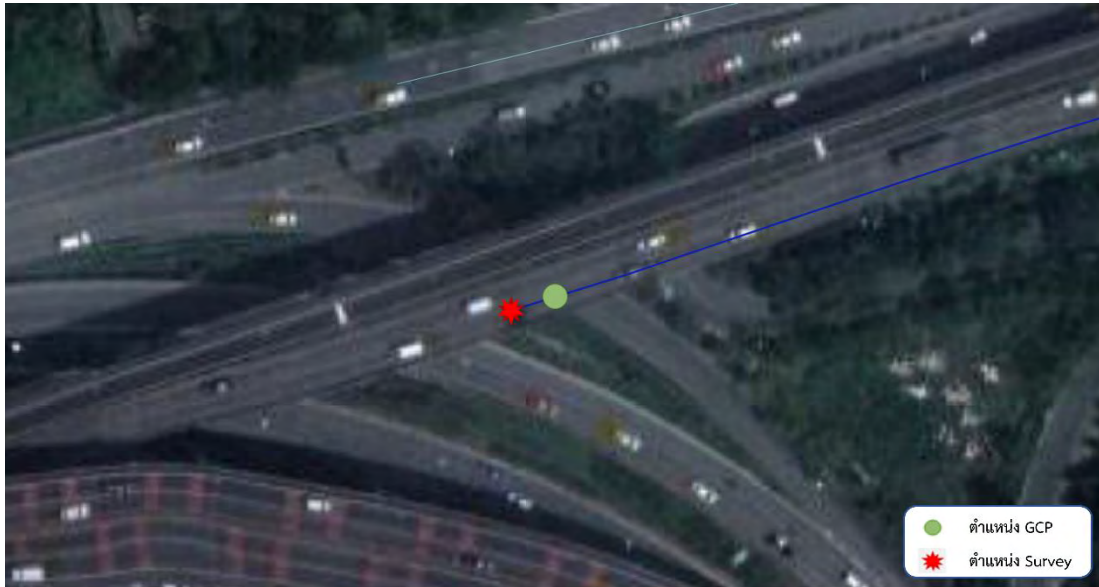
รูปที่ 16 แสดงจุด GCP และจุดที่ทำการตรวจสอบ ตำแหน่งที่ 15 แขวงทางหลวงธนบุรี สายทาง 341 ตอนควบคุม 0100
