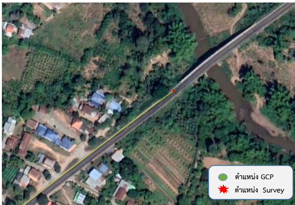
รูปที่ 314 แสดงจุด GCP และจุดที่ทำการตรวจสอบ ตำแหน่งที่ 71 แขวงทางหลวงขอนแก่นที่ 2 (ชุมแพ) สายทาง 0228 ตอนควบคุม 0100
