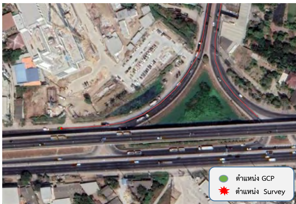
รูปที่ 339 แสดงจุด GCP และจุดที่ทำการตรวจสอบ ตำแหน่งที่ 96 แขวงทางหลวงนครปฐม สายทาง 3524 ตอนควบคุม 0100
