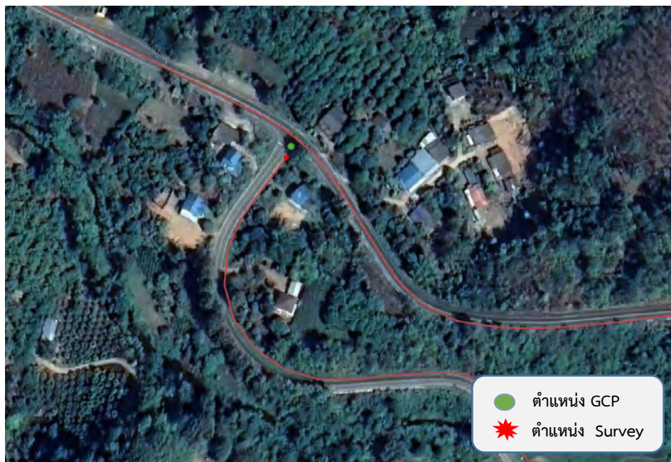
รูปที่ 269 แสดงจุด GCP และจุดที่ทำการตรวจสอบ ตำแหน่งที่ 26 แขวงทางหลวงน่านที่ 2 สายทาง 1188 ตอนควบคุม 0200
