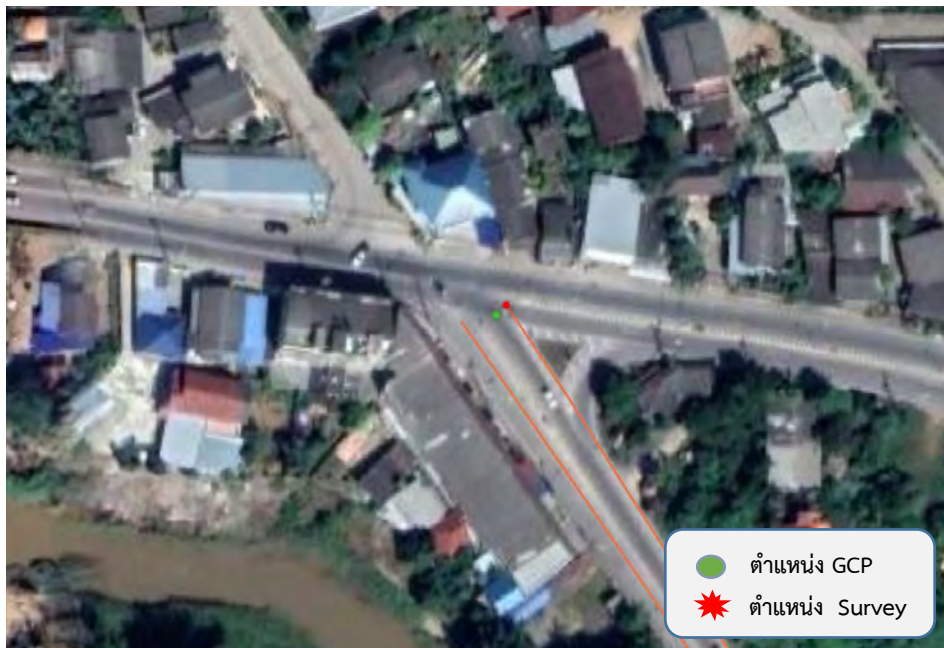
รูปที่ 277 แสดงจุด GCP และจุดที่ทำการตรวจสอบ ตำแหน่งที่ 34 แขวงทางหลวงเชียงรายที่ 2 สายทาง 1410 ตอนควบคุม 0100
