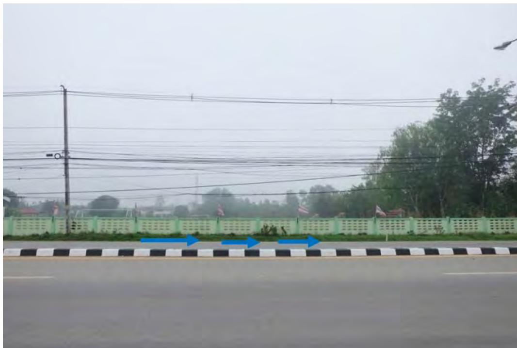
รูปที่ 2.4-13 จุดที่เกิดปัญหาริเวณหน้าโรงเรียนบ้านด่านลานหอยวิทยา (ตรงข้ามโรงพยาบาลบ้านด่านลานหอย) กม.147+400
