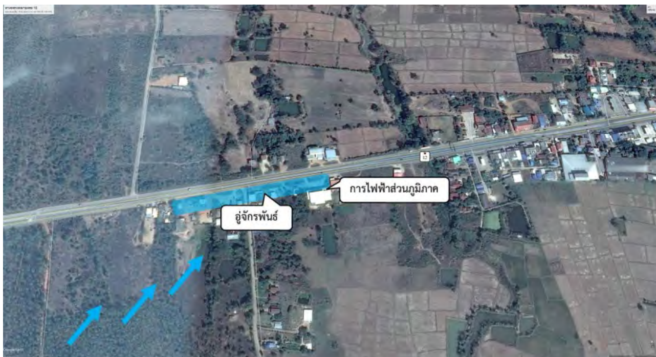
รูปที่ 2.4-10 ลักษณะการไหลท่วมสายทางหลวงหมายเลข 12 บริเวณ กม.143+600 ถึง กม.143+700
