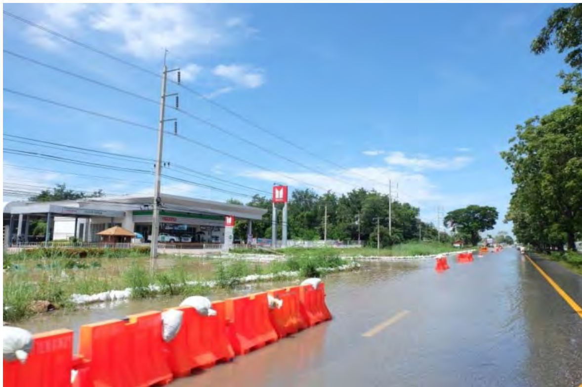
รูปที่ 2.4-19 ตัวอย่างลักษณะการเกิดภัยน้ำท่วมบริเวณสายทางหลวงหมายเลข 1 ประมาณช่วง กม.391+700
