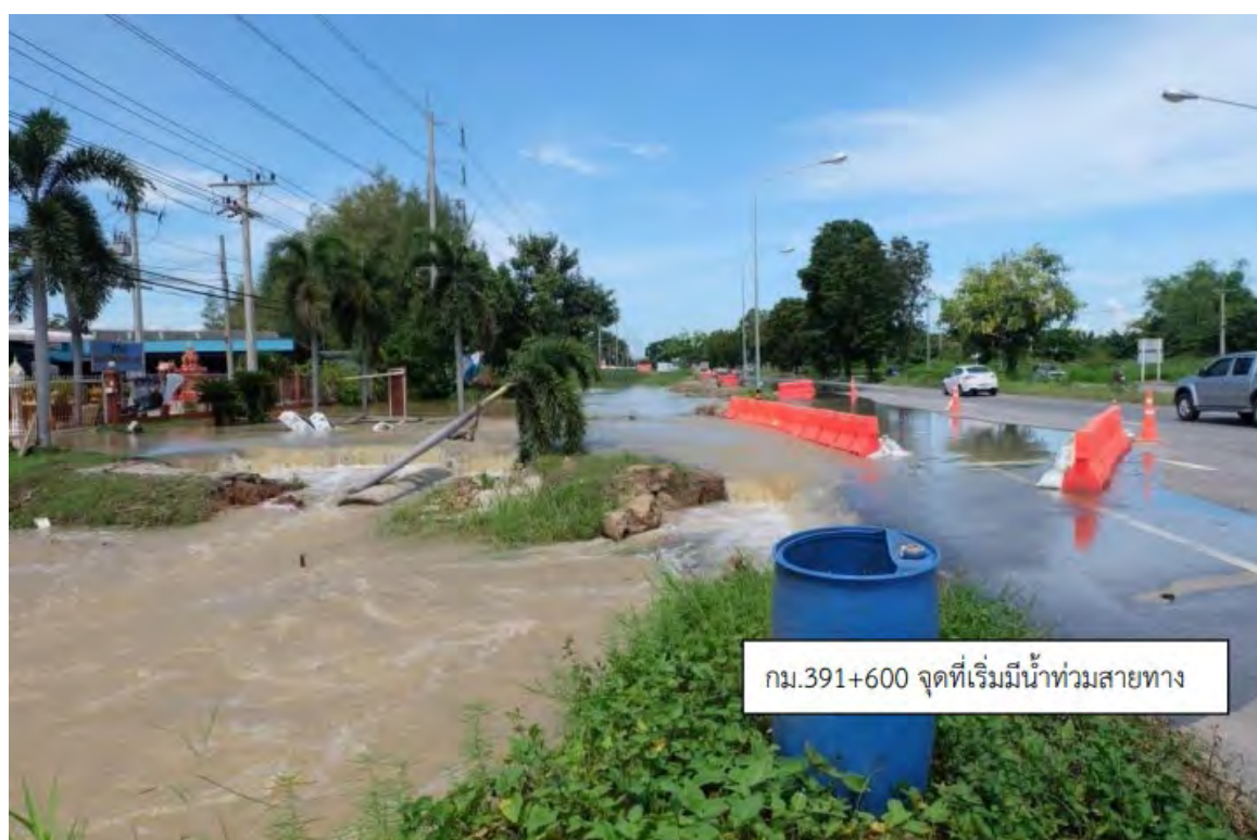
รูปที่ 2.4-20 จุดที่พบน้ำท่วมทางเชื่อมทางหลวง และเป็นจุดที่น้ำไหลย้อนกลับไปท่วมสายทางหลวง
