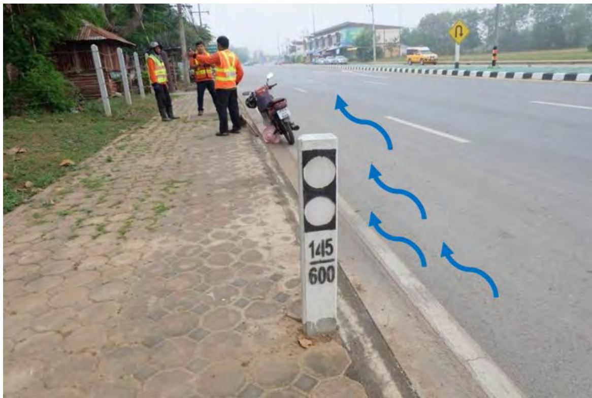
รูปที่ 2.4-11 จุดที่เกิดปัญหาบริเวณหน้ากรมป่าไม้กม.145+600
