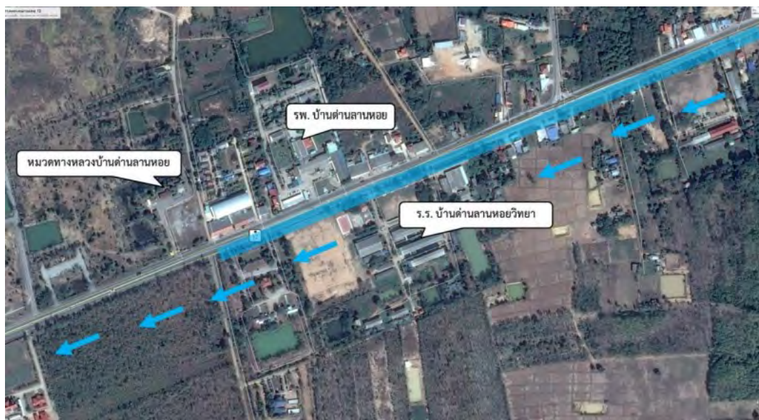
รูปที่ 2.4-14 ลักษณะการไหลท่วมสายทางหลวงหมายเลข 12 บริเวณ กม.147+400
