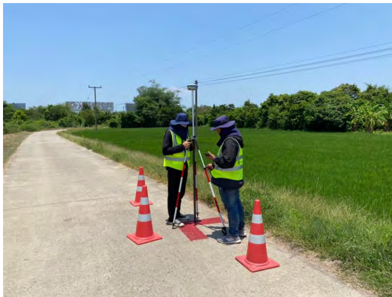
รูปที่ 15 แสดงการรังวัดจุดควบคุมภาคพื้น
