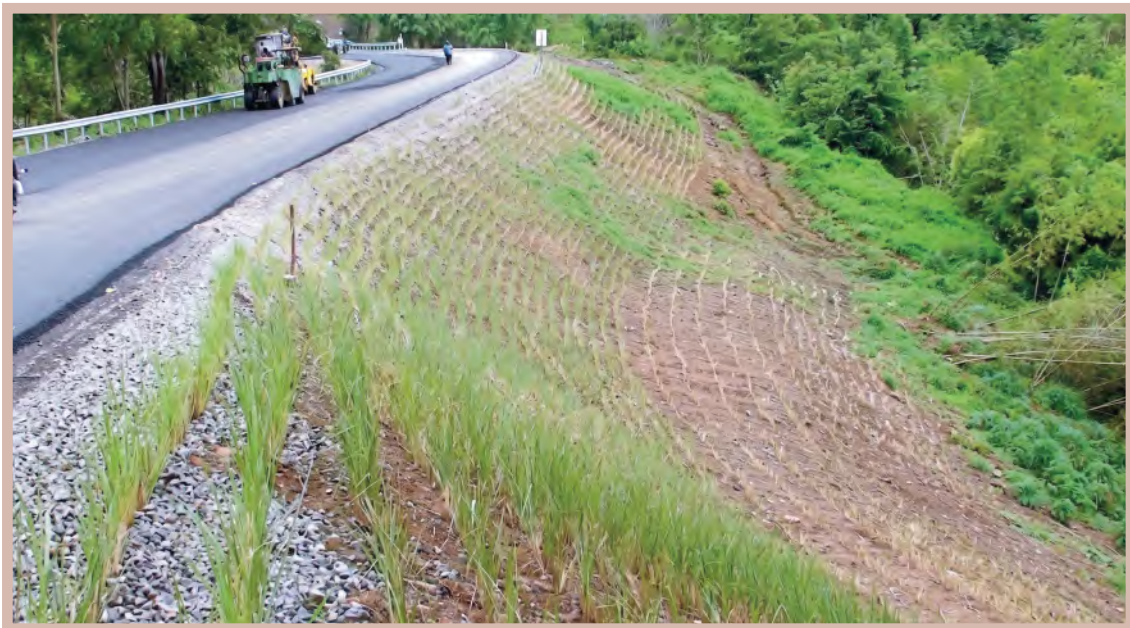
รูปที่ 3-4 การปลูกหญ้าแฝกบริเวณเชิงลาดถนน
