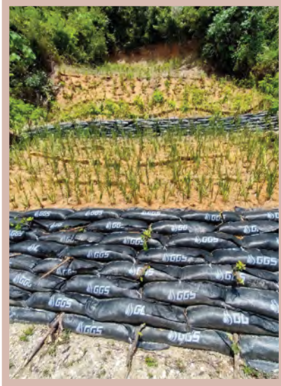
รูปที่ 3-12 ตัวอย่างการใช้กระสอบแบบมีปีกร่วมกับมาตรการชีววิศวกรรมเพื่อป้องกันการกัดเซาะและเสริมเสถียรภาพลาดดิน ทล. 4029 ตอนกะทู้ - ป่าตอง กม.0+125 จังหวัดภูเก็ต ที่มา : อภินิติ (2569) เอกสารการบรรยาย โครงการฝึกอบรม “ครูหญ้าแฝก” รุ่นที่ 3 61
