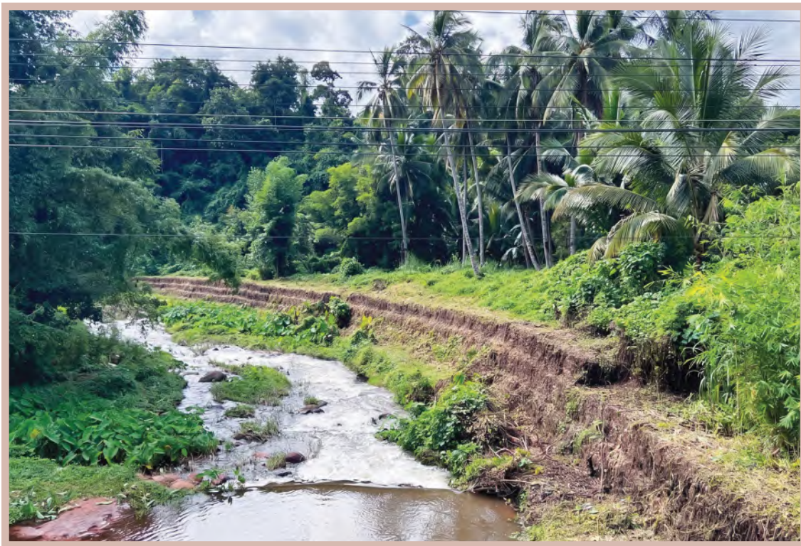
รูปที่ 3-10 การป้องกันเสถียรภาพเชิงลาดตลิ่งน้ำด้วยกอ่งหินเกเบียน ที่มา : ถ่ายโดยคณะผู้จัดทำ วันที่ 25 กันยายน 2568 อำเภอ น้ำปาด จังหวัดอุตรดิตถ์
