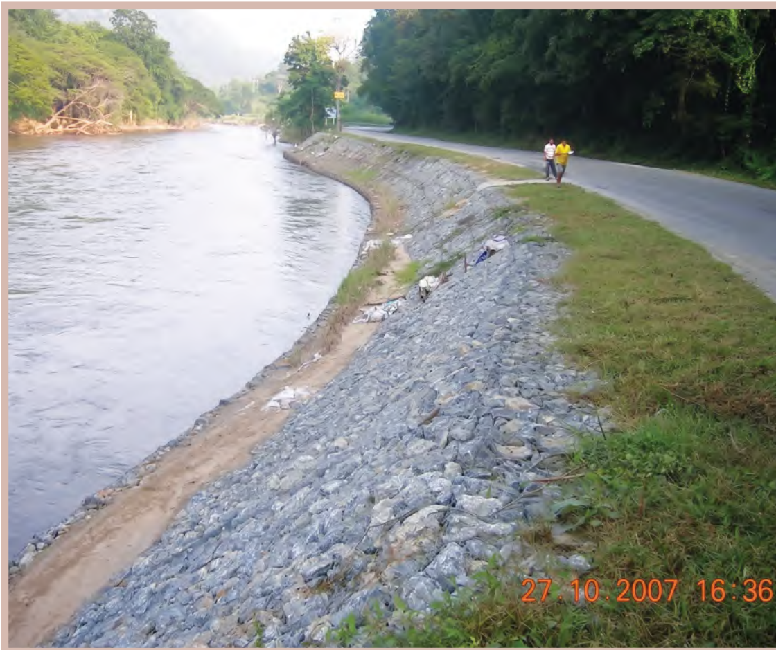
รูปที่ 2-27 ตัวอย่างการป้องกันการกัดเซาะเชิงลาดด้วย reno mattress ของกรมทางหลวง ที่มา : อัครพัฒน์ สว่างสุริย์ เอกสารประกอบการบรรยาย 41
