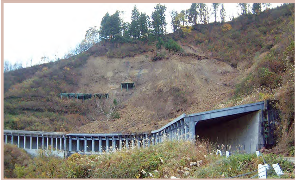
รูปที่ 2-21 ตัวอย่างโครงสร้างคลุมถนนกันหินถล่ม (rock shed) ที่มา : อัครพัฒน์ สว่างสุริย์ เอกสารประกอบการบรรยาย 35
