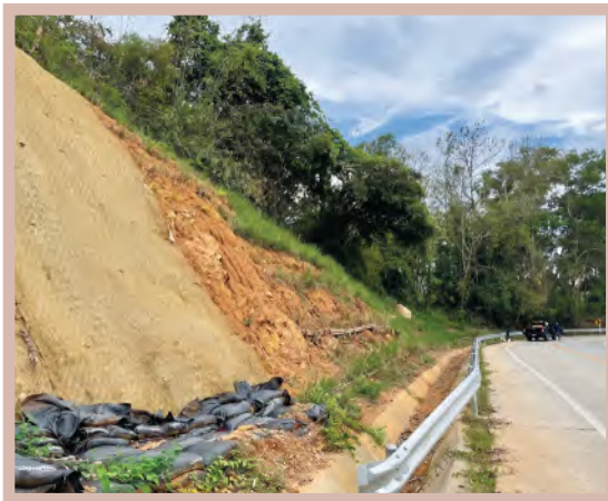
รูปที่ 3-13 การเสริมเสถียรภาพลาดถนนด้านหลังผาโดยใช้กระสอบแบบมีปีก เสาค้ำเสริมและตะปูดิน บริเวณบ้านปากเหมือง ถนน กจ.3091 อำเภอทองผาภูมิ จังหวัดกาญจนบุรี ที่มา : ประกิต ไชยศรี และคณะ (2565) 62
