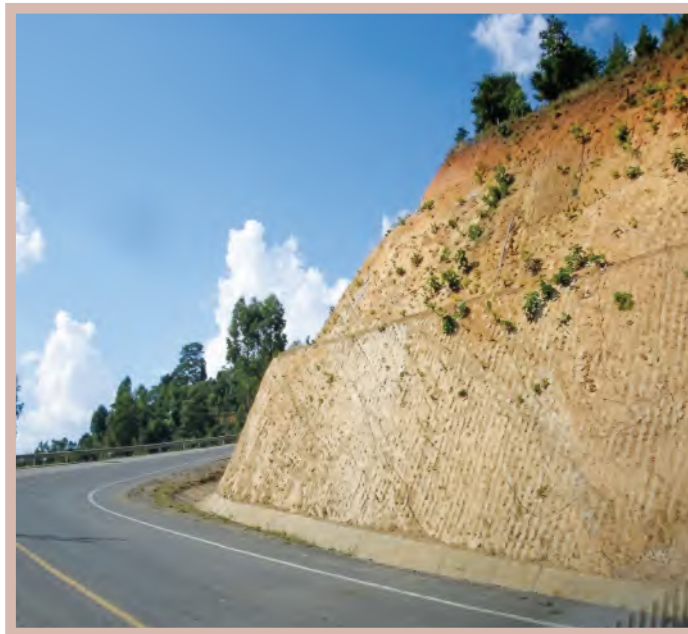
รูปที่ 2-13 ตัวอย่างการทำขั้นบันไดเชิงลาด (benching of slope) ที่มา : อัครพัฒน์ สว่างสุริย์ เอกสารประกอบการบรรยาย 27
