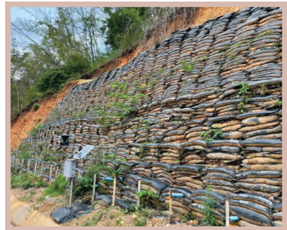
รูปที่ 3-13 การเสริมเสถียรภาพลาดถนนด้านหลังผาโดยใช้กระสอบแบบมีปีก เสาค้ำเสริมและตะปูดิน บริเวณบ้านปากเหมือง ถนน กจ.3091 อำเภอทองผาภูมิ จังหวัดกาญจนบุรี ที่มา : ประกิต ไชยศรี และคณะ (2565) 62
