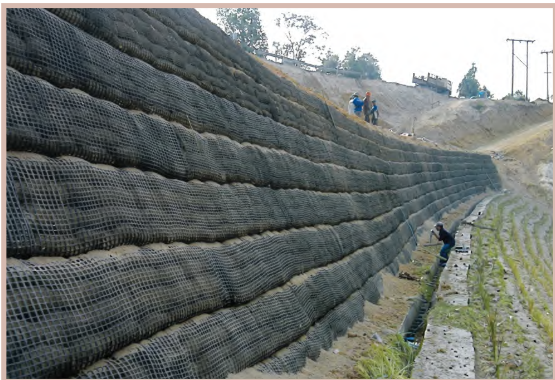
รูปที่ 3-15 ลาดดินเสริมแรงด้วยตาข่ายสังเคราะห์และปิดผิวหน้ากระสอบดิน (reinforced soil slope with geogrid reinforcement and soil bag facing)
