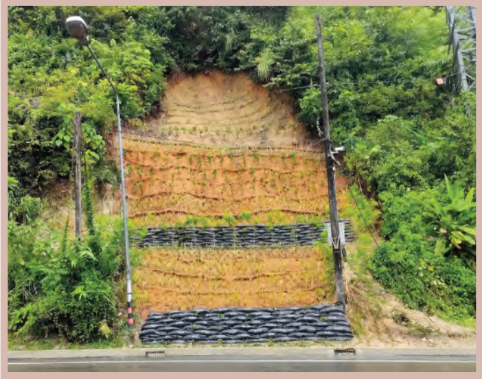
รูปที่ 3-12 ตัวอย่างการใช้กระสอบแบบมีปีกร่วมกับมาตรการชีววิศวกรรมเพื่อป้องกันการกัดเซาะและเสริมเสถียรภาพลาดดิน ทล. 4029 ตอนกะทู้ - ป่าตอง กม.0+125 จังหวัดภูเก็ต ที่มา : อภินิติ (2569) เอกสารการบรรยาย โครงการฝึกอบรม “ครูหญ้าแฝก” รุ่นที่ 3 61
