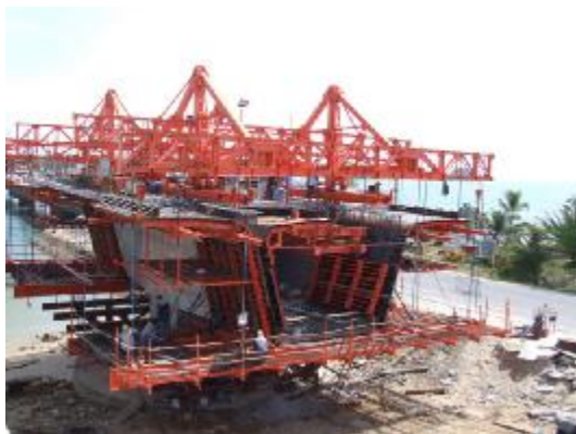
แบบหล่อคอนกรีตด้านนอก (Outer Formwork) และ ด้านใน (Inner Formwork)
