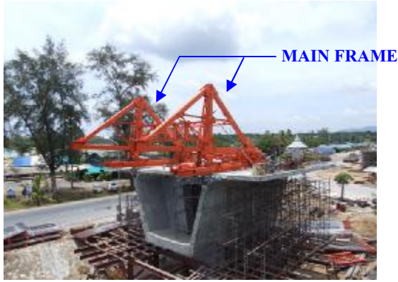
Main Frame และ Transverse Truss
