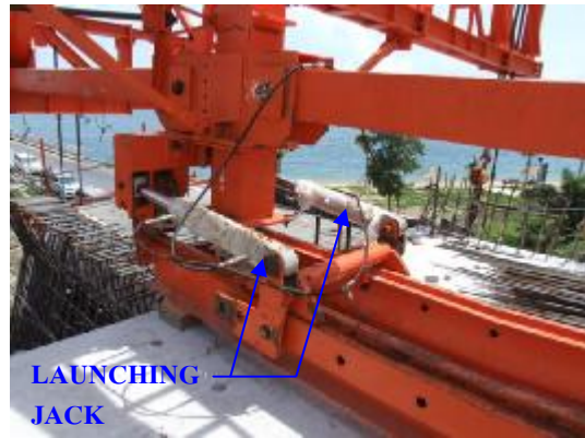
Rail Beam และ Launching Jack
