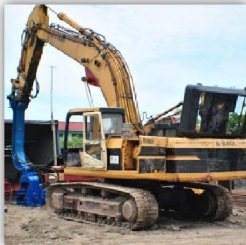
Backhoe ตัดหัวจับ
