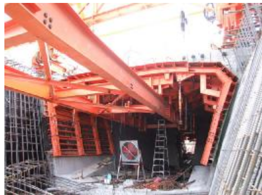
แบบหล่อคอนกรีตด้านนอก (Outer Formwork) และ ด้านใน (Inner Formwork)
