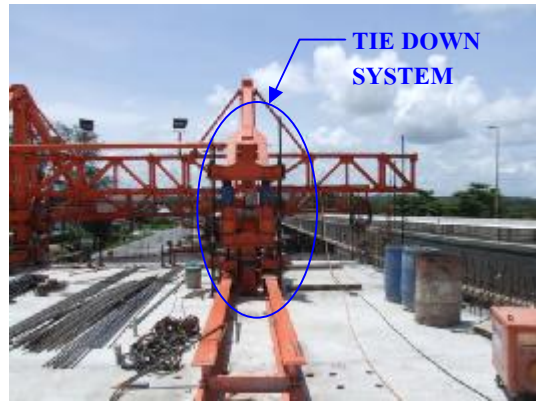
Front Reaction Jack และระบบ Tie Down
