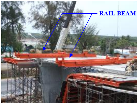
Rail Beam และ Launching Jack
