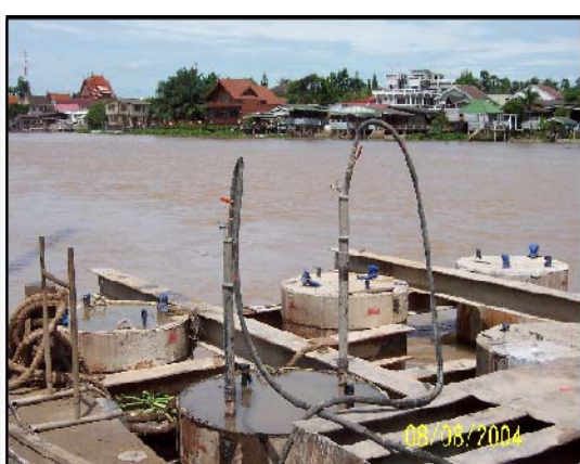
3.6อัดฉีดน้ำปูนที่ปลายเสาเข็ม ( Compaction Grouting Or Toe Grouting)
