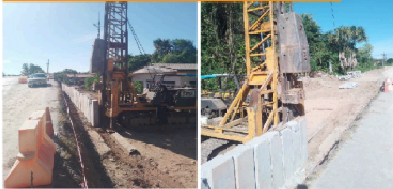
Step 1 : วางแนวและตอกเข็มพืดให้ได้ความลึกตามแบบ
