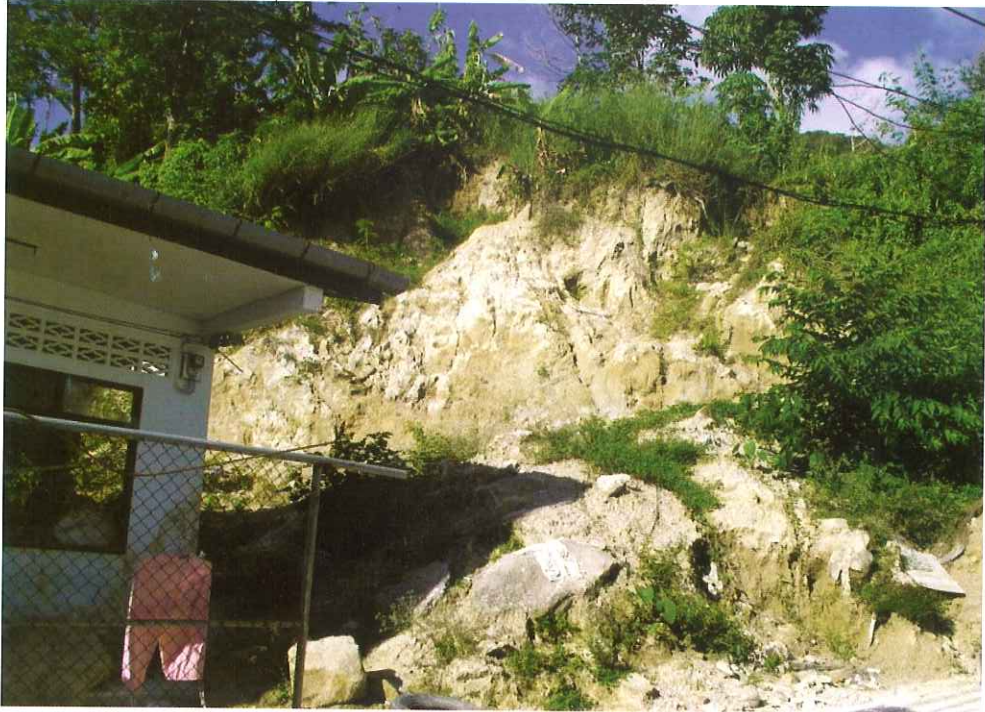
ข. ความเสียหายจากดินถล่มบริเวณชุมชนบ้านกะหลิม (วันที่ 14 ตุลาคม พ.ศ. 2547)
