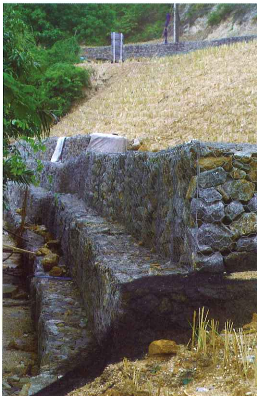
รูปที่ 21 รูปแบบการปกคลุมหน้าดินและการระบายน้ำ
