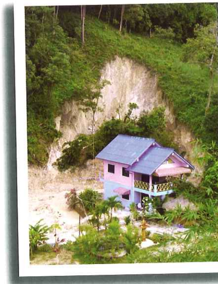
ก. ดินถล่มบริเวณทางขึ้นถนน 50 ปี วันที่ 21 ตุลาคม พ.ศ. 2546
