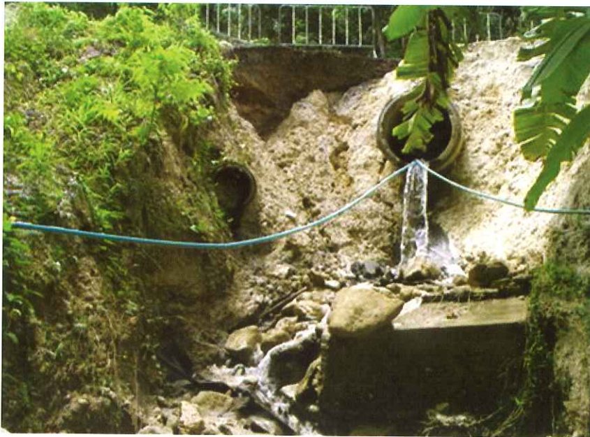
รูปที่ 8 การก่อสร้างถนนปิดร่องเขาและมีท่อระบายน้ำที่มีขนาดไม่เหมาะสม
