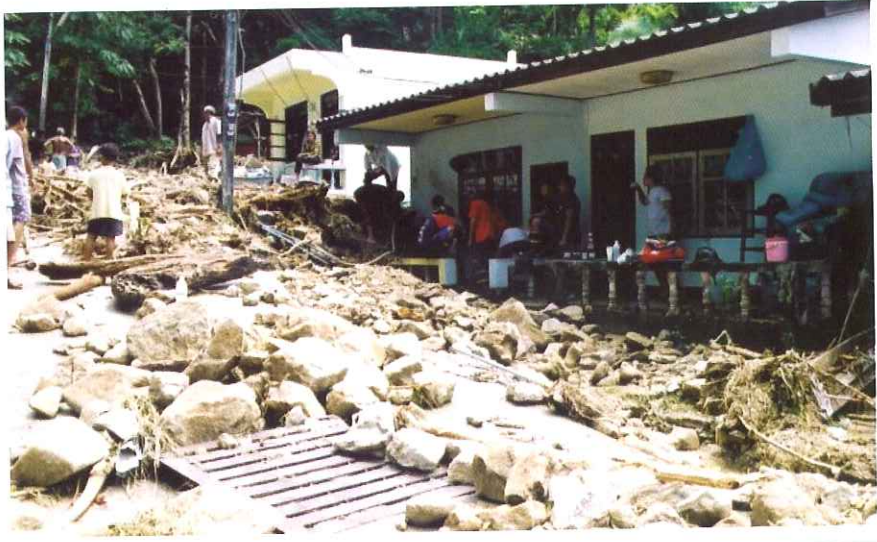
รูปที่ 9 ท่อระบายน้ำไม่สามารถรับน้ำจากภูเขาได้ วันที่ 14 ตุลาคม พ.ศ. 2547 (ภาพจากงานป้องกันและบรรเทาสาธารณภัยเมืองป่าตอง)
