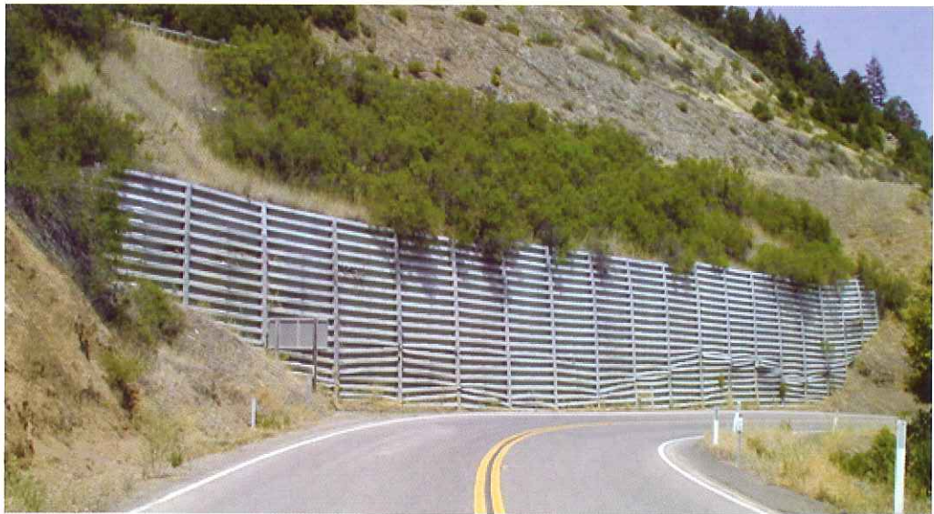
รูปที่ 26 กำแพงกันดิน (Retaining Walls)
