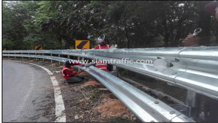
ภาพที่ 15 ราวเหล็กกลูกฟูกกันรถแบบ Double W-Beam Guardrail (แบบสองชั้น)
