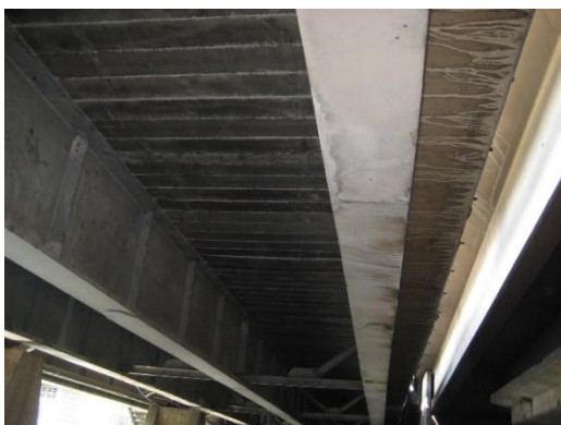
Steel Girder (SG)
