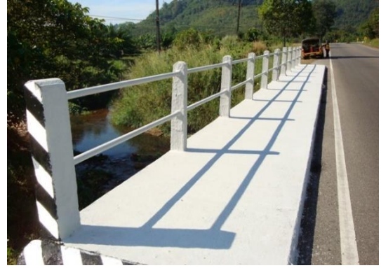
ราวท่อเหล็กเสา คสล.
