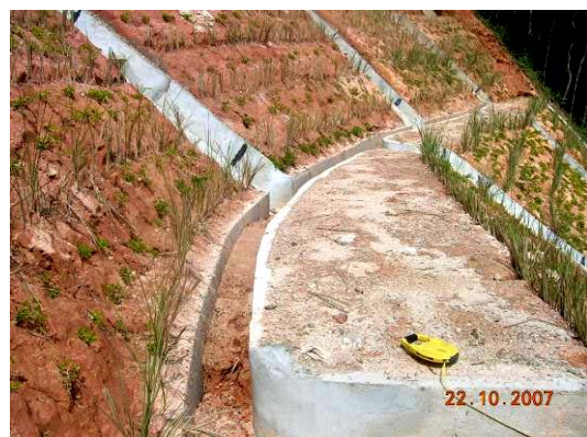
(ฉ) ตะกอนดินใน Interceptor
