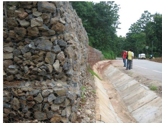
(ข) Side Ditch ที่มีการทำความสะอาด เอาเศษดินออกทำให้การระบายน้ำดี
