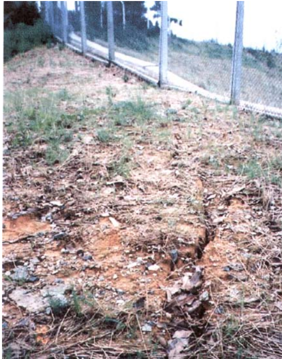
(ก) Tension Crack ของเชิงลาดดินถม
