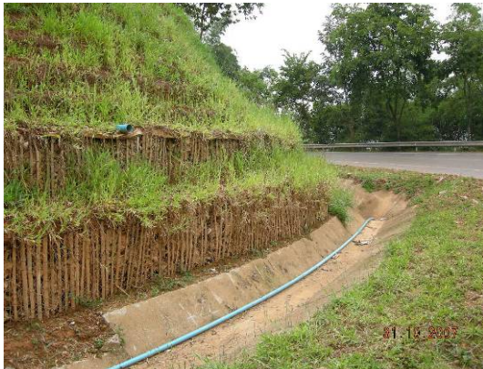
(ก) Side Ditch ที่มีการบำรุงรักษาดี ไม่มีตะกอนดินในราง
