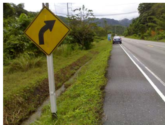
(ง) รางระบายน้ำที่มีการบำรุงรักษาดี (ตัดหญ้าบริเวณขอบรางระบายน้ำ ตามระยะเวลา(Routine Maintenance))
