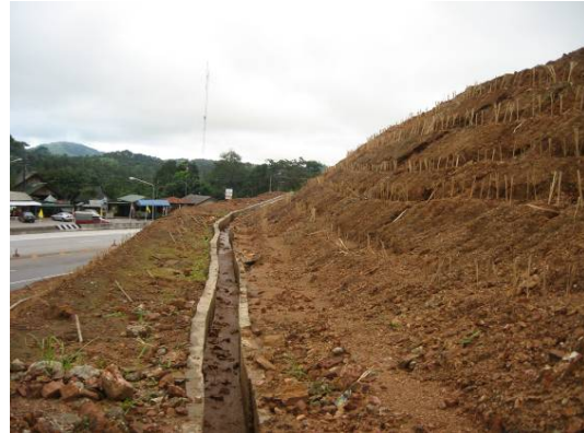
(ง) ตะกอนดินลงมาที่บ่อเต็มวาง Interceptor
