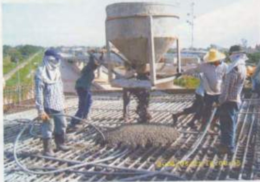
รูปที่ 5 การเทคอนกรีต
