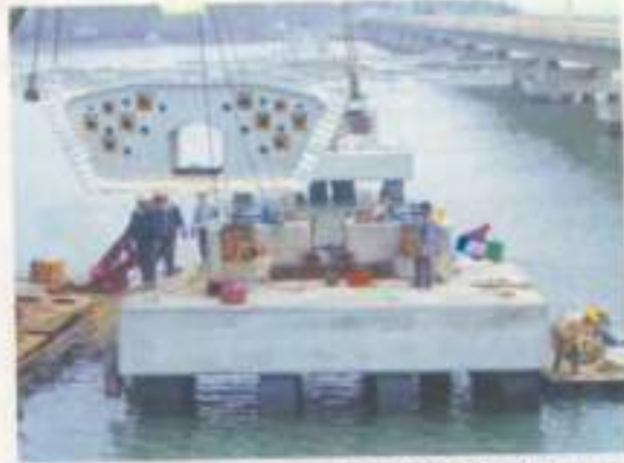
ยก Pier Segment วางบน Pier Column
