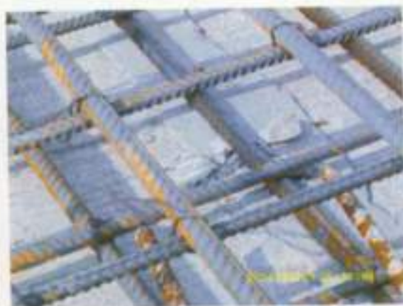
ตรวจสอบระยะ Covering ของเหล็กล่าง
