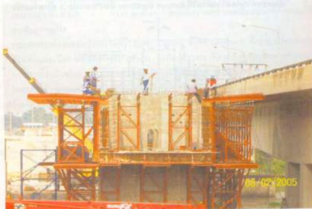
การกำหนดระดับก่อสร้าง Top Slab ของ Pier Segment
