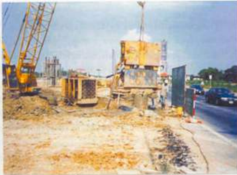
เครื่อง Vibrator ตีงปลอกเหล็กขึ้น
