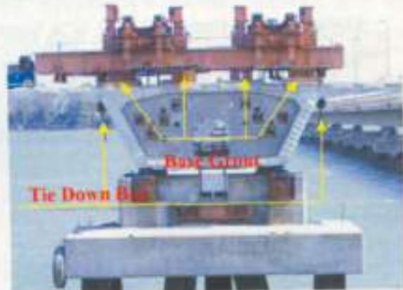
ติดตั้ง Support Beam บน pier
