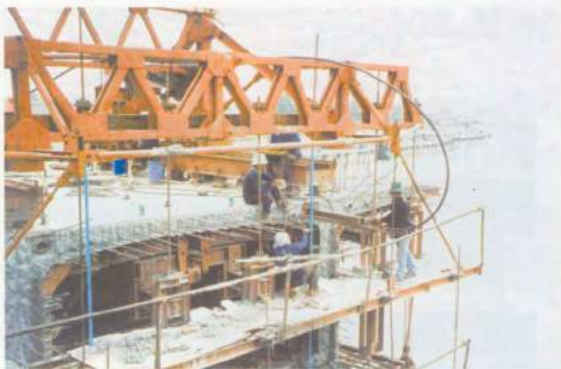
ร้อยลวดอัดแรงใน Longitudinal Tendon
