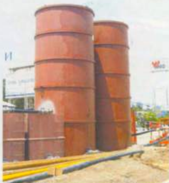
รูปที่ 7 ตั้งเก็บของเหลวพยางเสถียรภาพหลุมเจาะ
