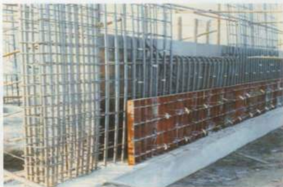
รูปที่ 6 งานหล่อกำแพง บนคานคอติน
