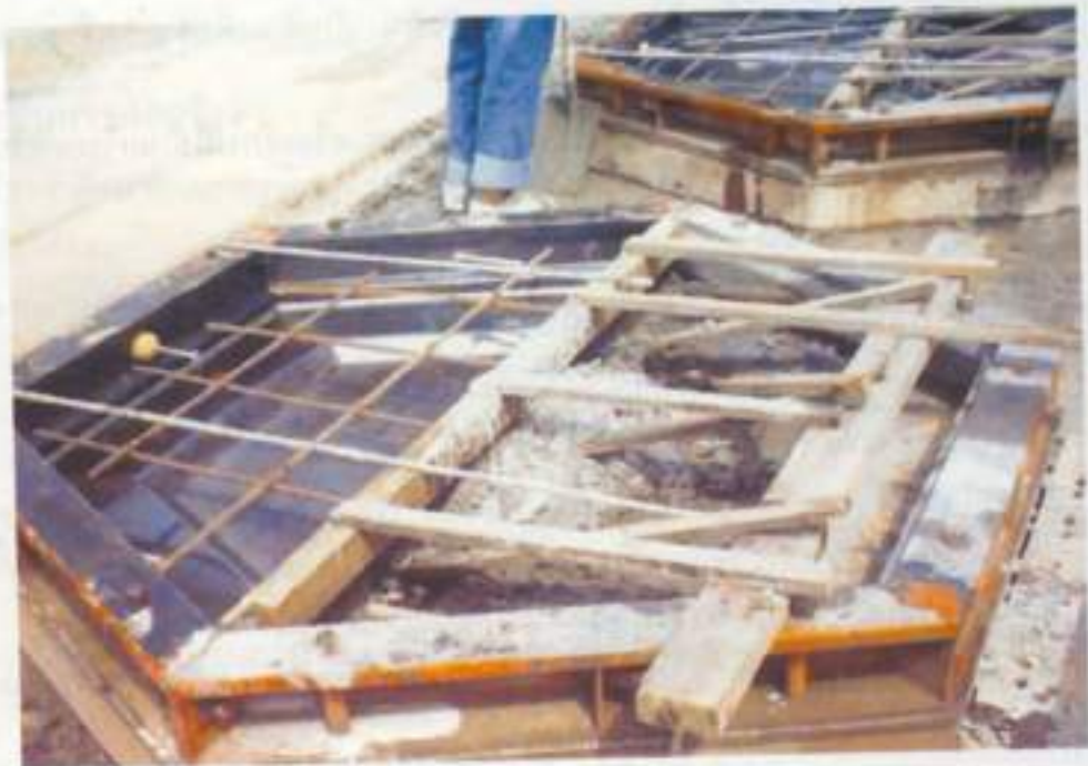
รูปที่ 9 แบบหล่อแผ่นผนังคอนกรีต ในการฉีกรังแผ่น
