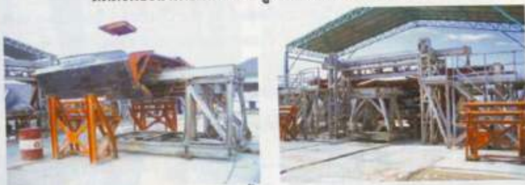
การติดตั้ง Inner Form
