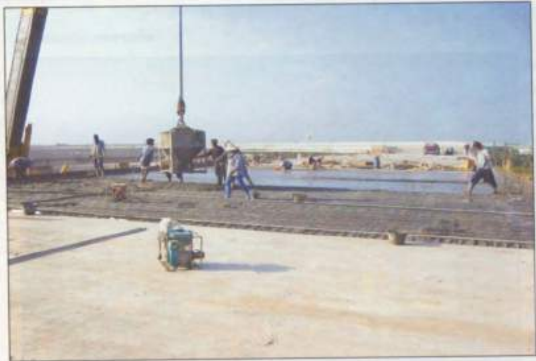
รูปภาพขณะเทคอนกรีตพื้นสะพาน
