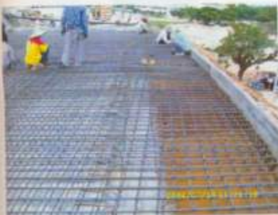
เสริมเหล็กในทางโค้ง
