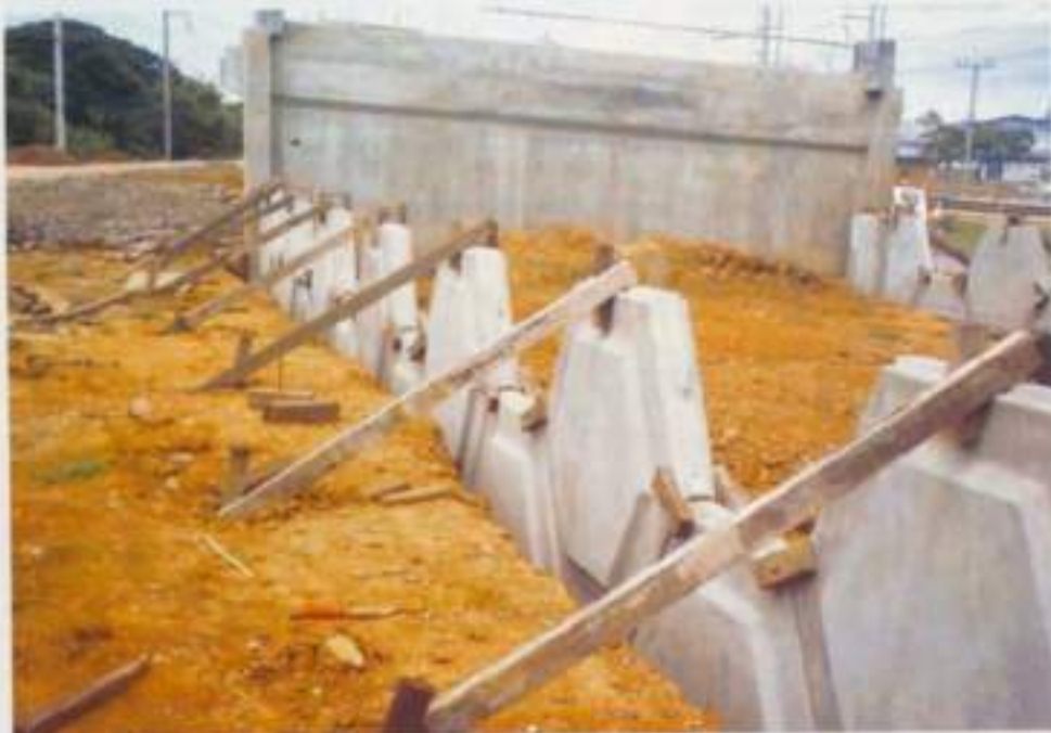
รูปที่ 23 การติดตั้งอุปกรณ์ค้ำยันแผ่นผนังคอนกรีต
