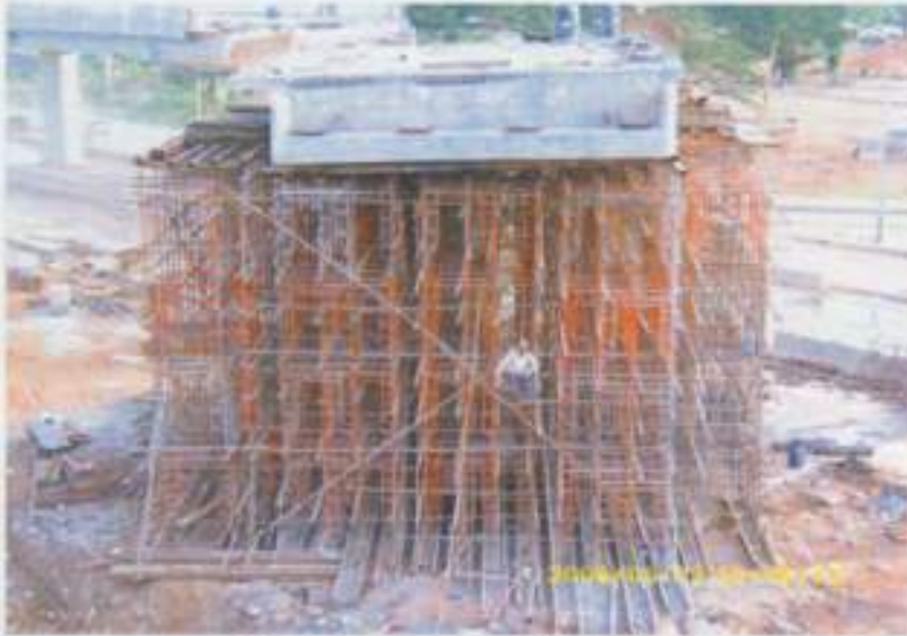
รูปที่ 6 การถอดแบบหลังเทคอนกรีต
