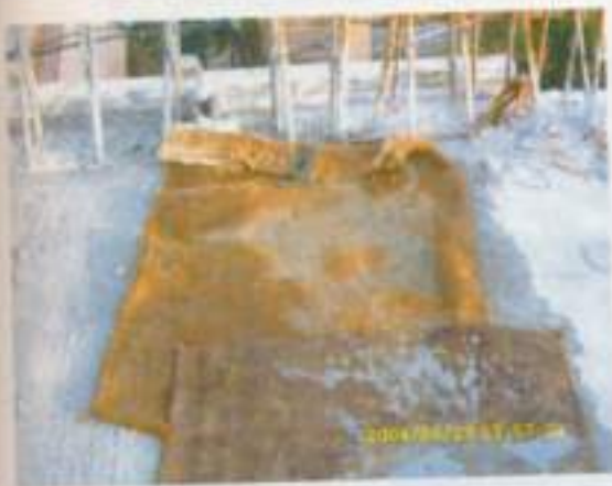
การป้มนคอนกรีตที่รอยต่อพื้นสะพาน
