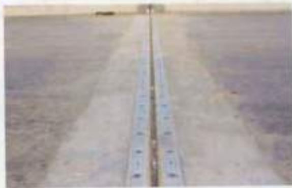
ภาพแสดงรอยต่อพื้นสะพาน Expansion Joint เมื่อแล้วเสร็จ
