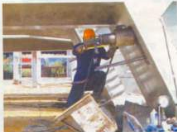
การตั้งลวดแนวขวาง
