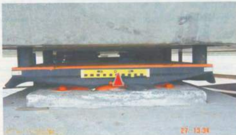
Pot Bearing ติดตั้งแล้วเสร็จได้ Precast Box segment รอการ Grout ด้วย Non-shrinkage
