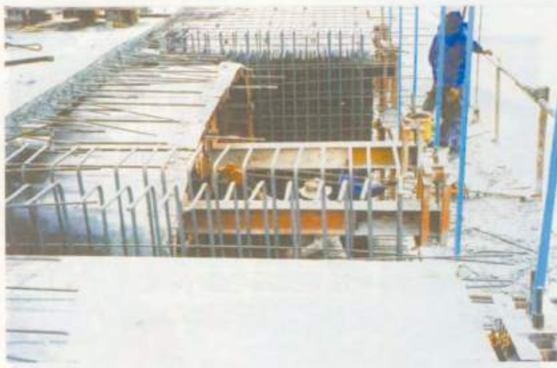
เลื่อนแบบแบบหล่อด้านใน (Inner Form) ของ Segment ด้วยรถทล เพื่อความสะดวก
