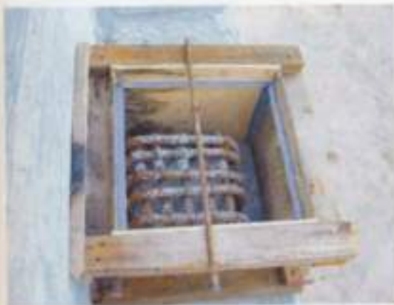
แบบหล่อ Seismic Buffer
