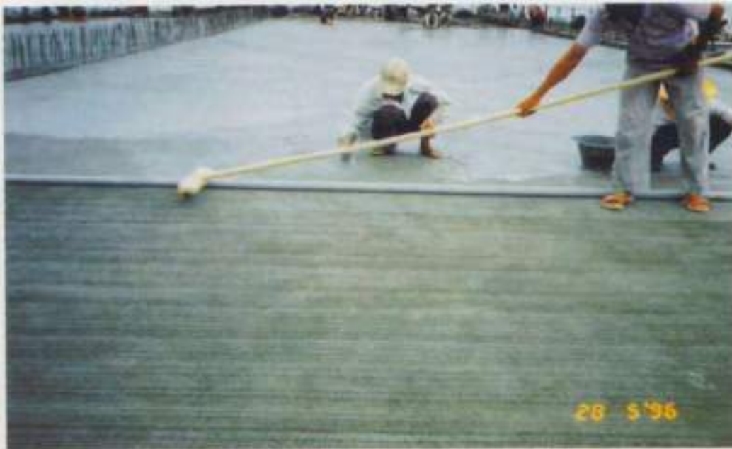
รูปที่ 14 งานตบแต่งผิวพื้นบนโดยใช้ Steel Trowel
