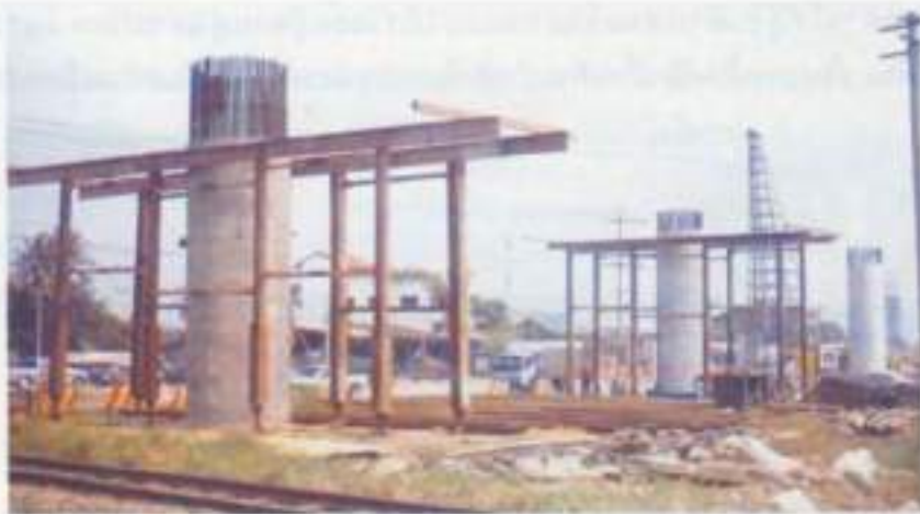
รูปที่ 7 การประกอบนั่งร้านรองรับแบบบริเวณเสา
