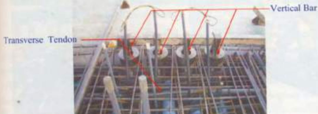
เหล็กเสริมและแนวลวด Prestress
