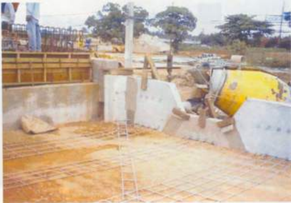
รูปที่ 29 การติดตั้งตะแกรงเหล็กบริเวณมุม Abutment ตามแบบ
