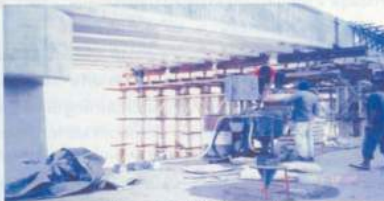
การตั้งลวดอัดแรงในบริเวณหน้างาน
