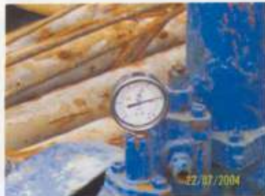
ระหว่างอัดน้ำปูน แรงดันจะค่อย ๆ เพิ่มขึ้น จนถึง 20 Bar หลังจากนั้น คงระดับแรงดันที่ 20 Bar นาน 5 นาที
