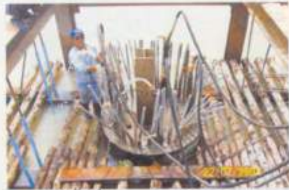
การอัดน้ำเพื่อตรวจสอบ Circuit Flushing
