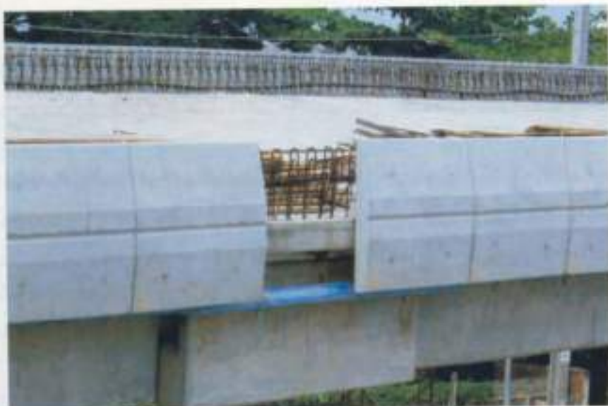
การติดตั้งแผ่นขอบทางคอนกรีตแบบหล่อสำเร็จ (Precast)
