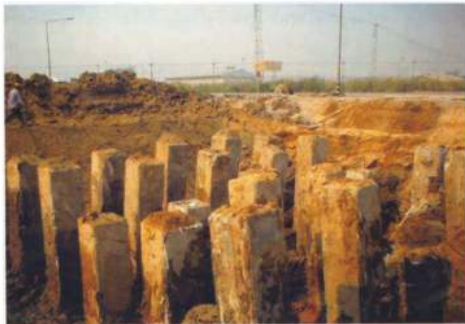
ภาพถ่ายแสดงการตอกเสาเข็ม
