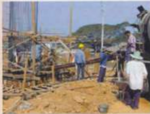
เทคอนกรีตฐานราก ด้วยราง
