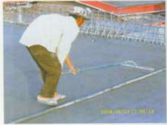
การทำผิวหน้าคอนกรีตตามแบบ
