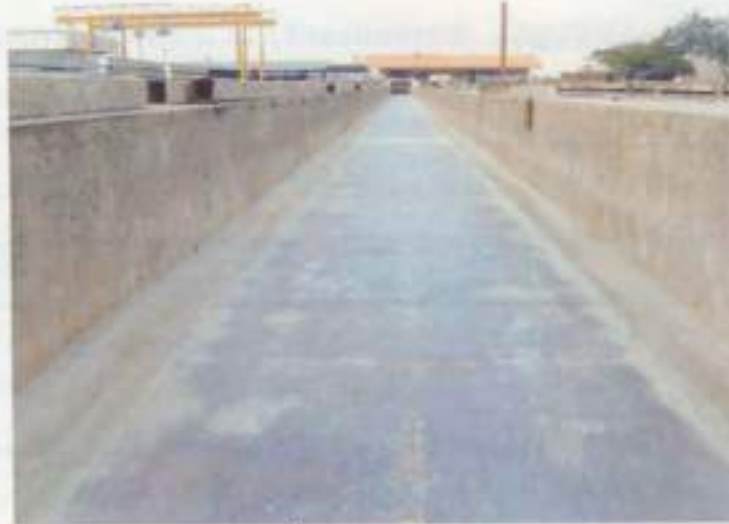
รูปที่ 2 ฐานหล่อคาน
