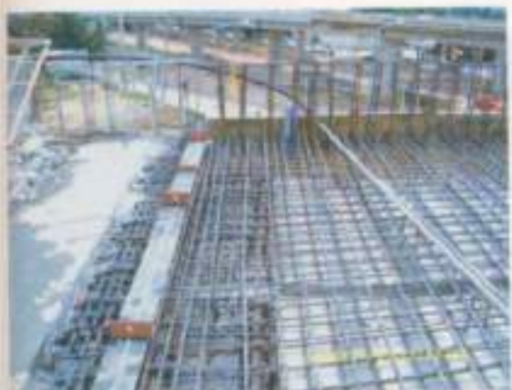
ติดตั้งรอยต่อพื้นสะพาน (Expansion Joint)
