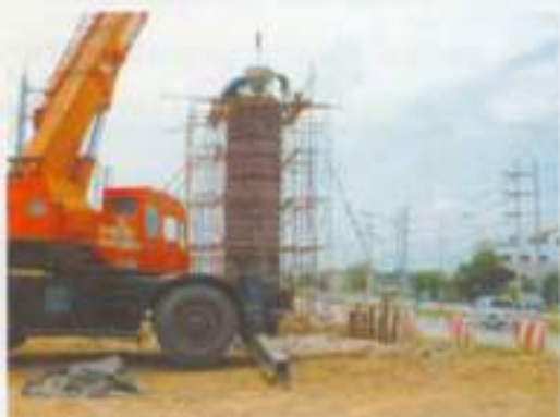
เทคอนกรีตด้วยรถยก ใช้ท่อยาง
