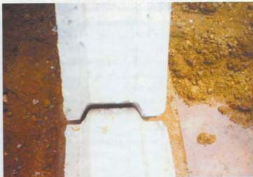
รูปที่ 16 การติดตั้งแผ่นผนังคอนกรีตให้ชิด
