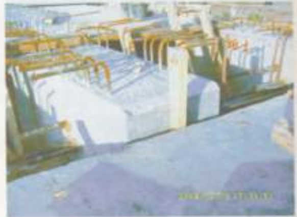
ตอกดีมไม้ยึดปลายคานไว้ทั้งสองปลาย
