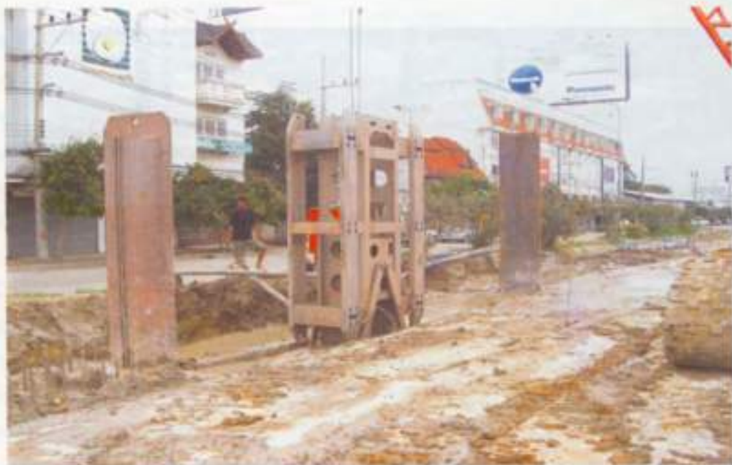
การขุด Diaphragm Wall
