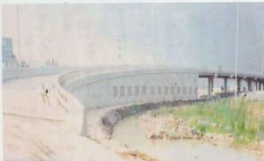
รูปที่ 2 Bridge Approach Structure ที่อยู่ในช่วงทางโค้ง
