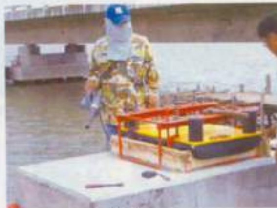
ติดตั้ง formwork
