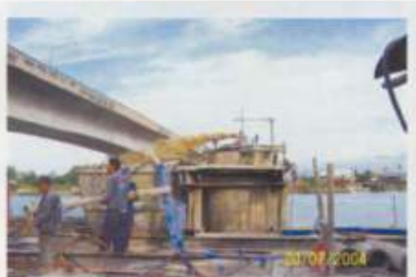
การทำความสะอาดกันหลุมเจาะโดยวิธี Air Lift
