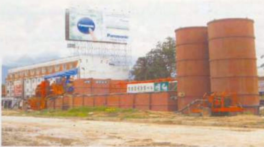
ชุดติดตั้ง Recycle Bentonite Slurry
