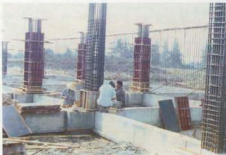
รูปที่ 5 งานหล่อเสา (Column)
