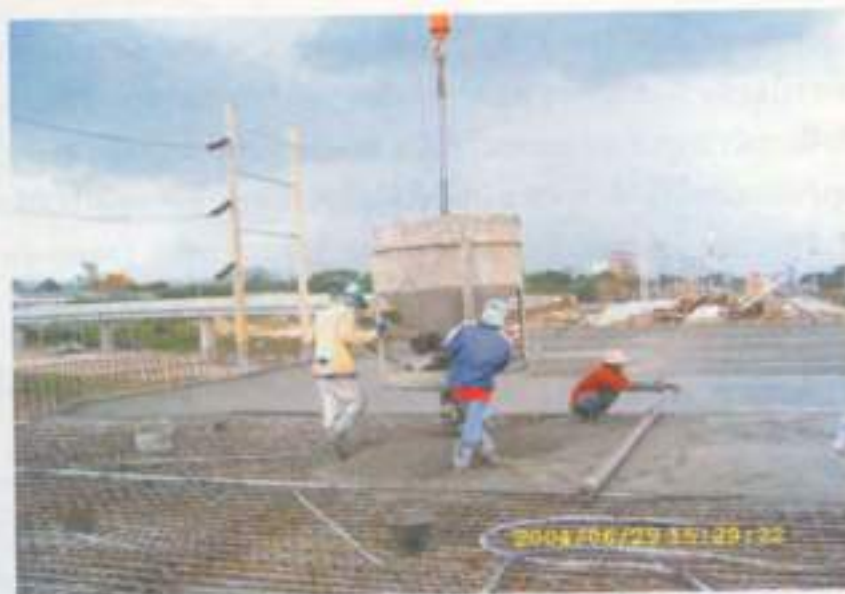
รูปที่ 11 การเทคอนกรีตพื้นบน(Top Slab)
