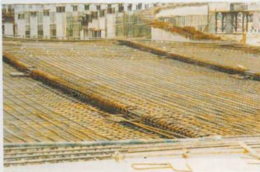
รูปที่ 11 งานเหล็กเสริมพื้นบน
