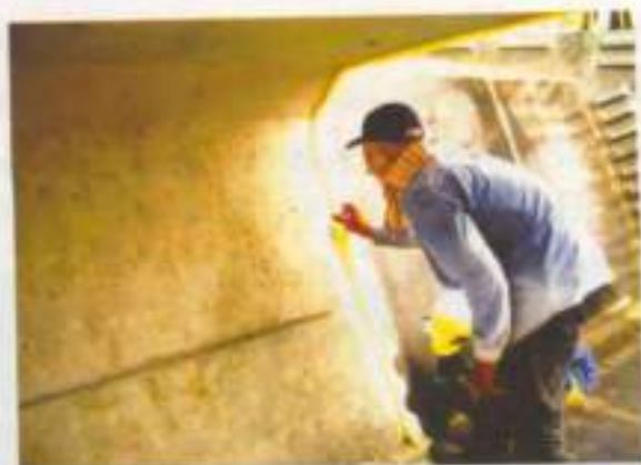
ติดตั้งฟองน้ำเพื่อป้องกันน้ำปูนไหลออกขณะเทคอนกรีต
