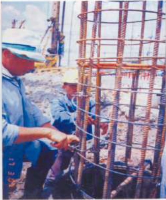
การต่อเหล็กเสริมของเสาเข็มเจาะ
