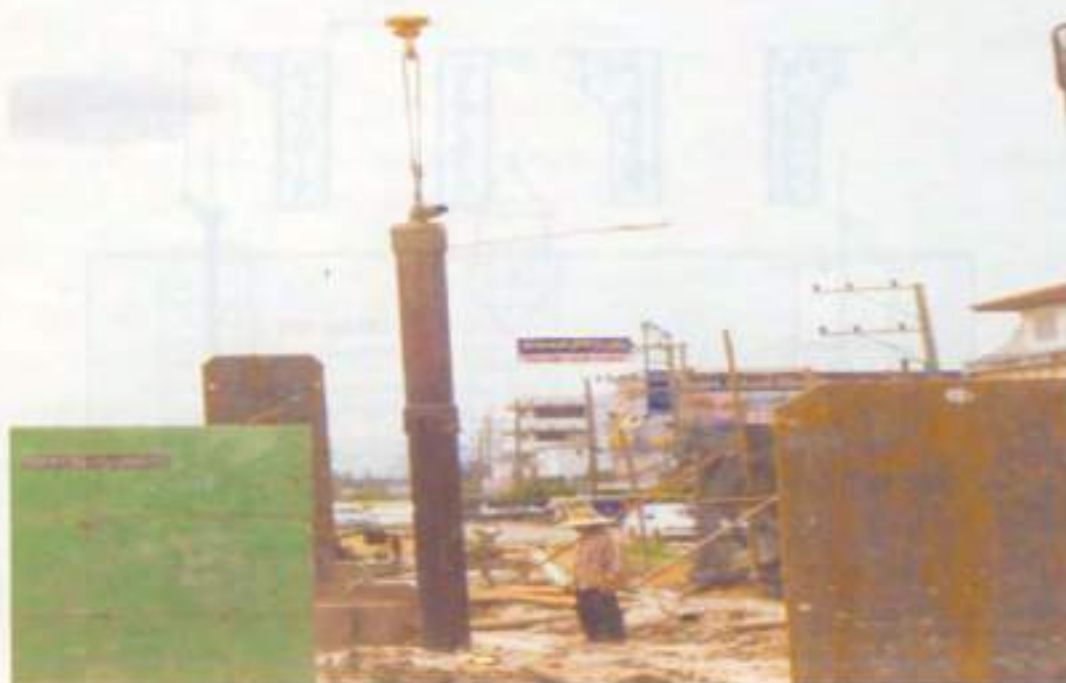
ท่อชุดทำความสะอาดกันหลุม
