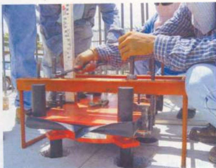
การติดตั้ง Pot Bearing ลงในช่อง Block Out ที่กำหนดไว้บนตอม่อสะพาน
