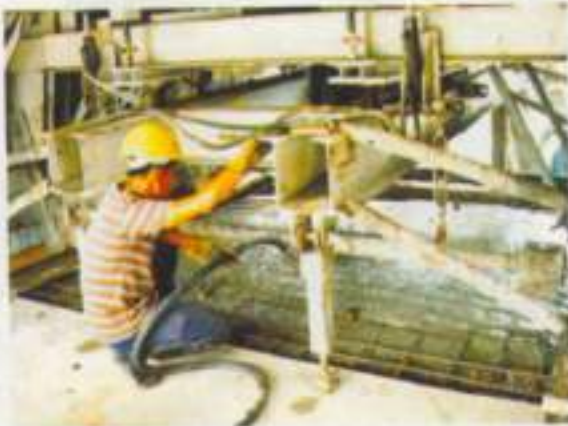
เท Bottom Slab
