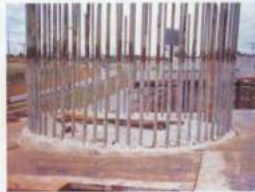
กำหนดระดับการเท ที่ห้องคานหัวเสา
