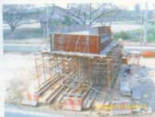
ประกอบแบบพร้อมเทคอนกรีตคานหัวเสา
