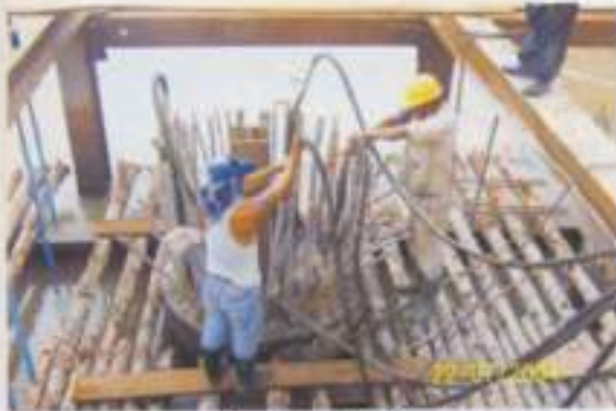
การติดตั้งท่ออัดน้ำปูน
