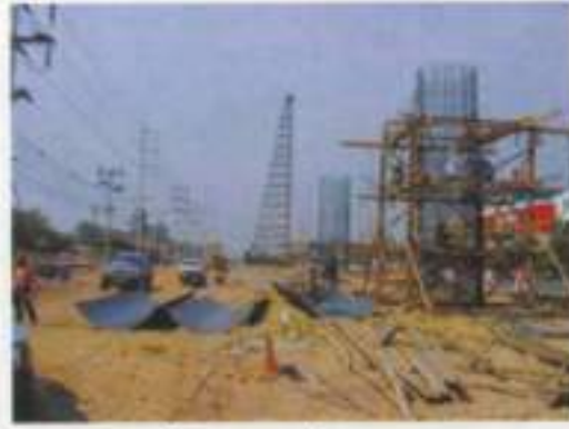
เตรียมแบบ ประกอบเสา
