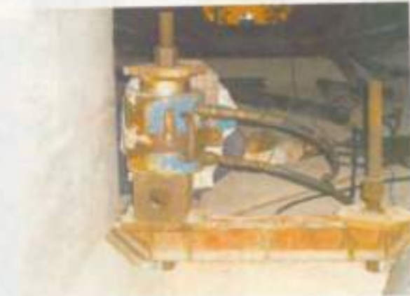
ตั้ง Tie down Bars ด้วยแรงขนาด 45 ตัน
