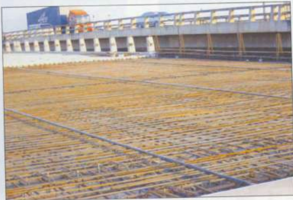
รูปภาพแสดงการจัดวางเหล็กกระดับตามแนวทิศทางจราจร
