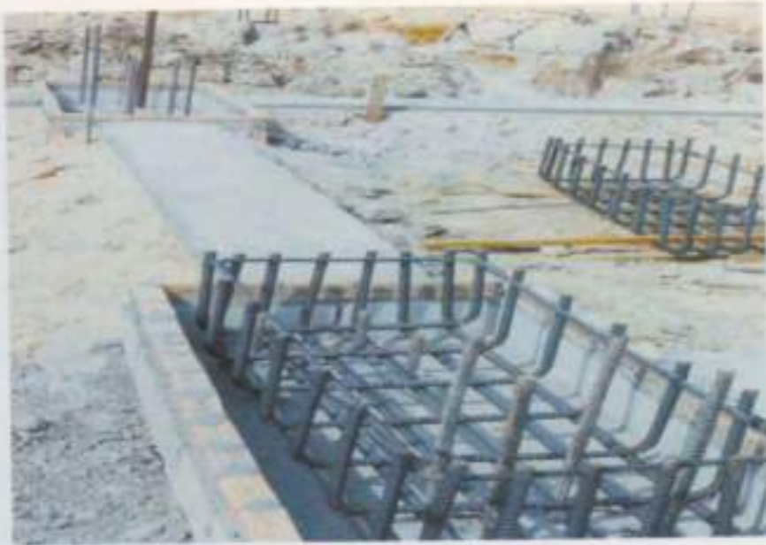
รูปที่ 3 งานเหล็กเสริมแผ่นหัวเข็ม
