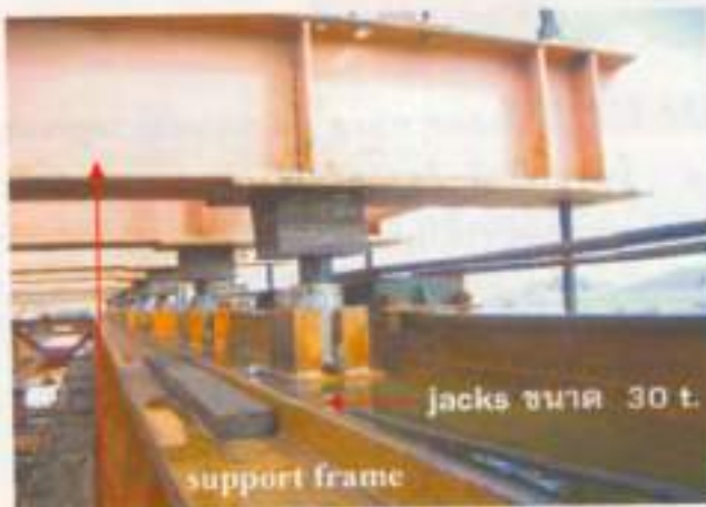
ติดตั้ง Jacks ขนาด 30 t. ใต้ Support Frame
