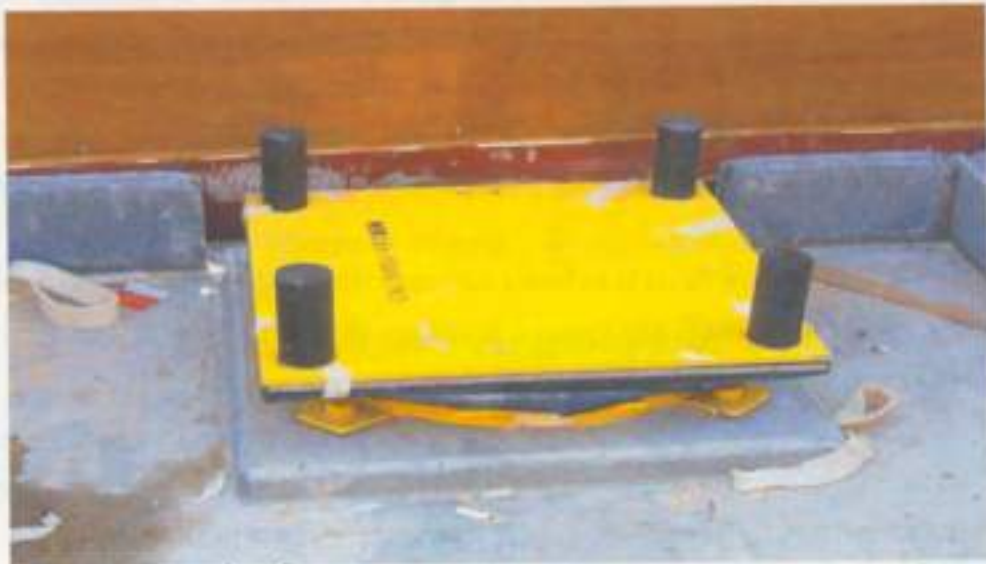
Pot Bearing ที่ติดตั้งบนค่อม โดยเทคอนกรีต Non-shrinkage แล้วเสร็จ
