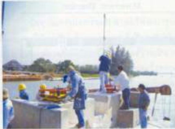
ติดตั้ง Pot Bearing
