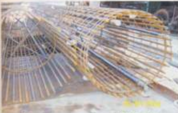
เหล็กเสริมของเสาเข็มเจาะที่ใส่ท่อเหล็ก จำนวน 4 ท่อ (สำหรับใช้ทดสอบความสมบูรณ์ ของเสาเข็ม และอัดฉีดน้ำปูน)
