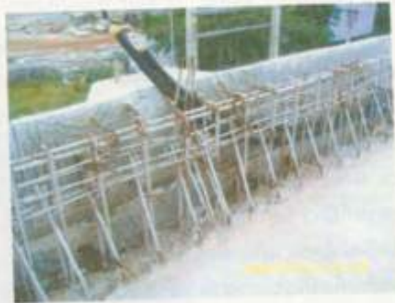
การร้อยท่อสายไฟฟ้าแสงสว่างที่ราวสะพาน
