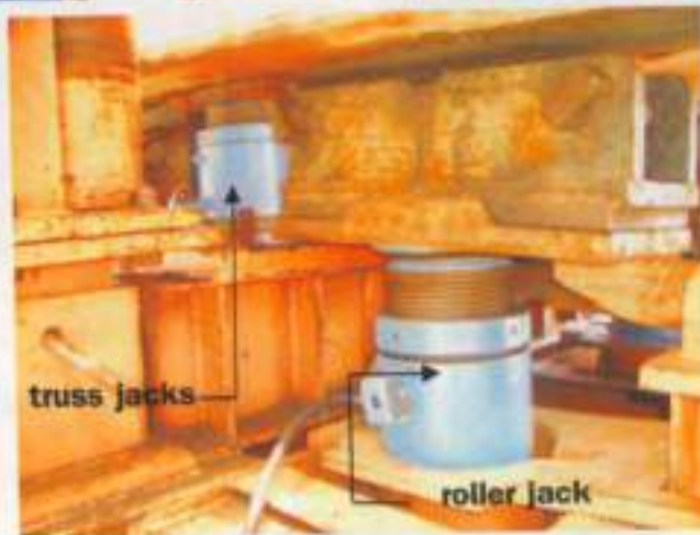
Roller jack และ Girder jacks
