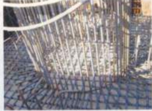
เสริมเหล็กเสา
