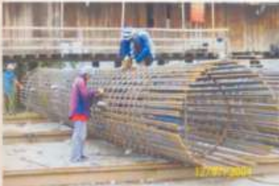
การผูกเหล็กเสริมของเสาเข็มเจาะ
