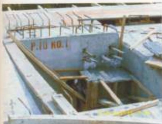
เหล็กเสริม Seismic Buffer ที่ริมคาน
