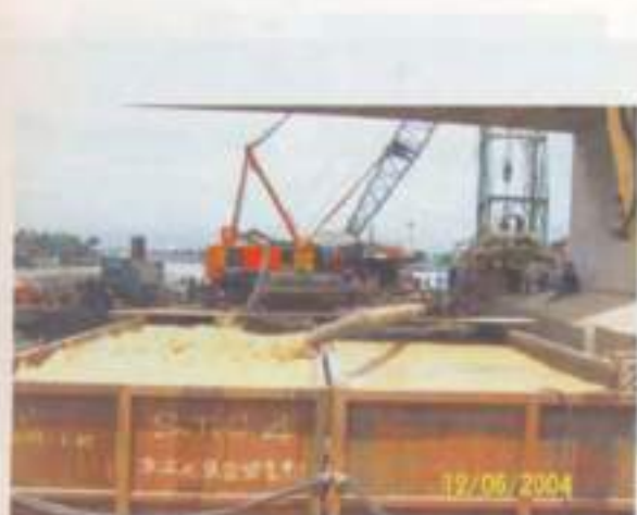
ถังพักตะกอนดิน ( Slush tank) จากการขุดเจาะ โดยวิธี Reverse Circulation
