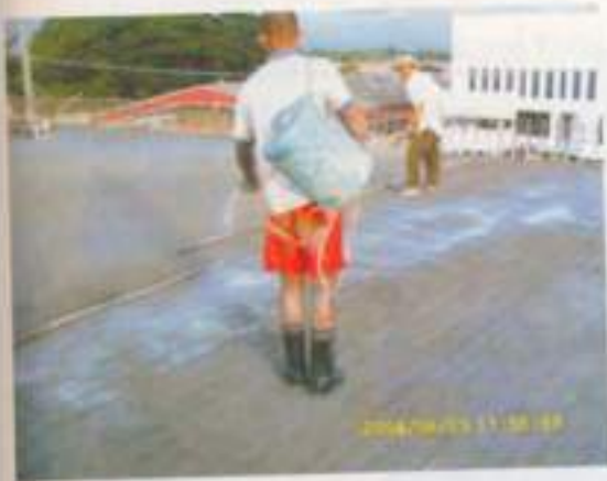
การป้มนคอนกรีต ด้วยน้ำยา
