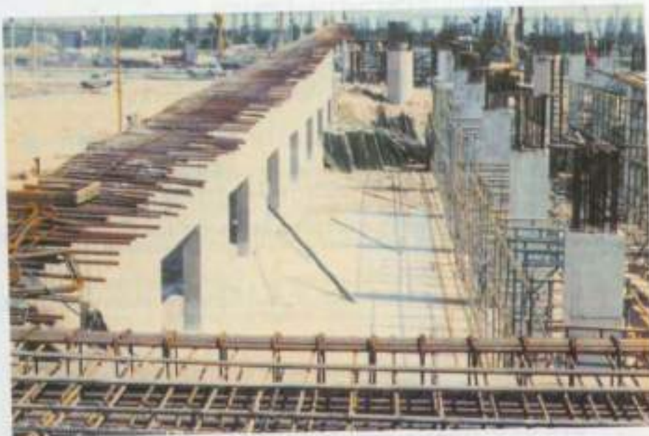
รูปที่ 8 เตรียมการตั้งนั่งร้านและค้ำยันเพื่อก่อสร้างคานบน และพื้นบน
