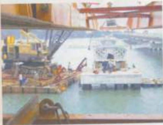
วาง Pier Segment เข้าตำแหน่ง
