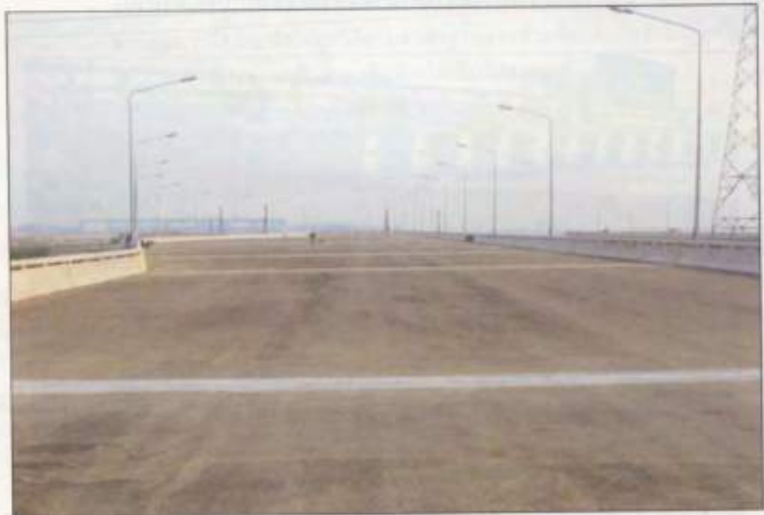
รูปภาพพื้นสะพานที่ก่อสร้างแล้วเสร็จ
