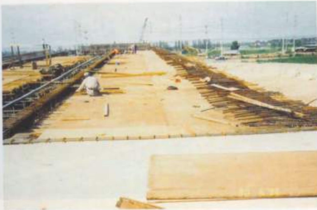
รูปที่ 10 งานแบบพื้นบน
