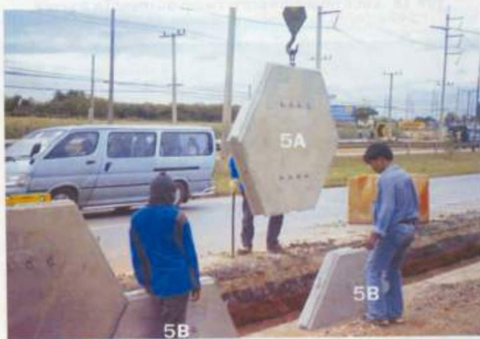
รูปที่ 21 การติดตั้งแผ่นผนังคอนกรีตรหัส 5A
