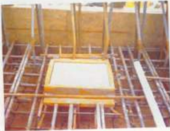
ติดตั้งแบบกันตำแหน่งท่อระบายน้ำ
