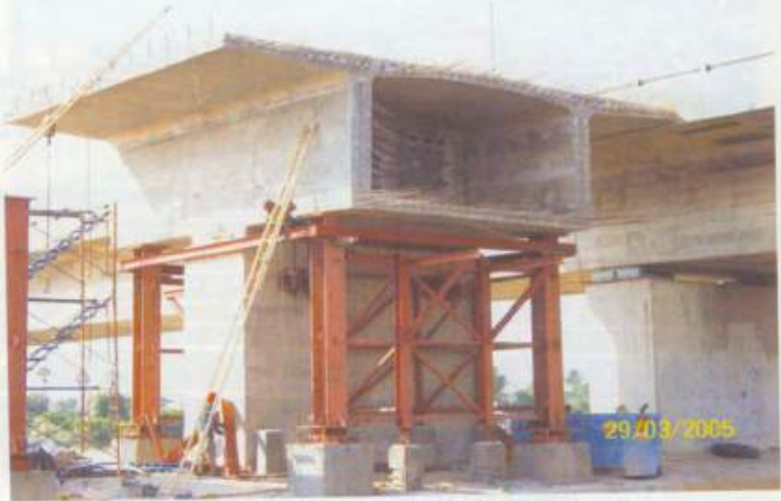
Pier Segment ที่หล่อคอนกรีตแล้วเสร็จ ยึดติดไว้กับนั่งร้านชั่วคราวด้วย Tie Down Bars
