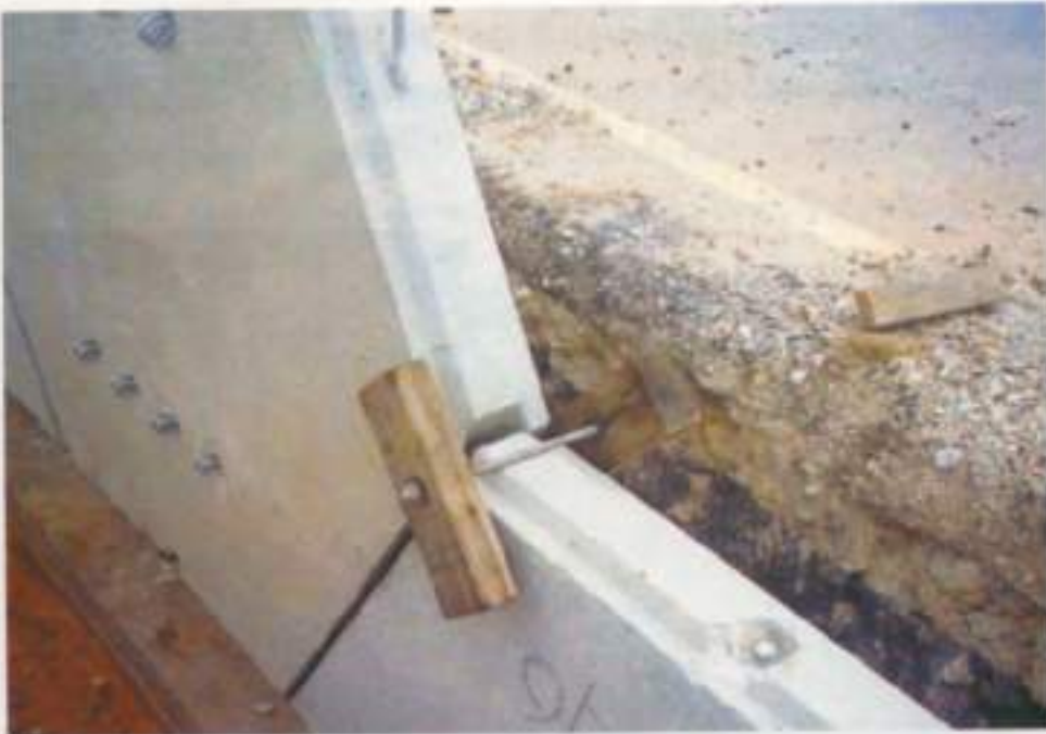
รูปที่ 22 การติดตั้งอุปกรณ์ยึดแผ่นผนังคอนกรีต
