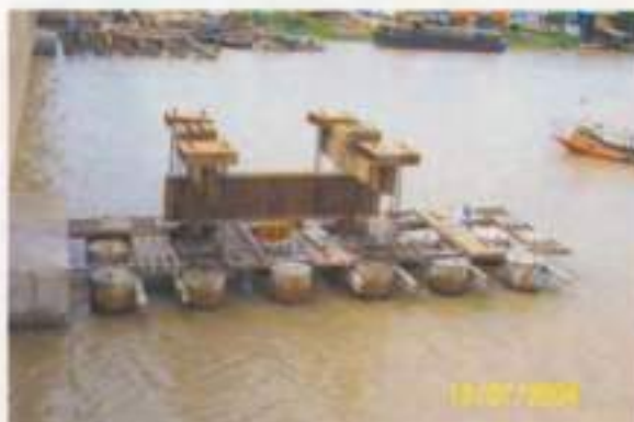
การทดสอบ Static Pile Load Test
