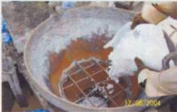
ใส่โฟมเม็ดลงไปนท่อ Tremie เพื่อแบ่งชั้นสารละลายกับคอนกรีตที่จะเท
