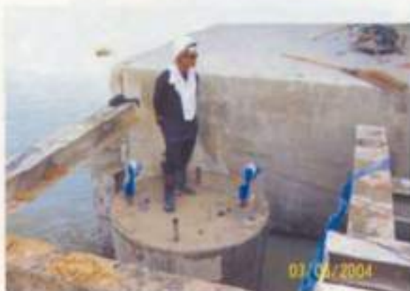
การทดสอบความสมบูรณ์ของเสาเข็มเจาะ
