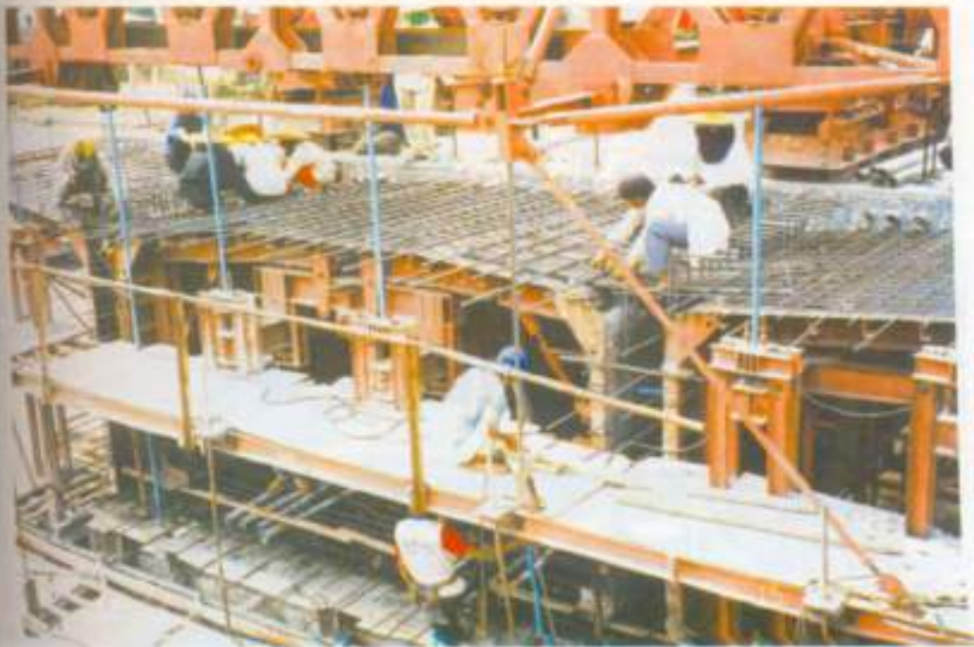
มุกเหล็กเสริมในพื้นที่บน (Top Slab) ของ Segment
