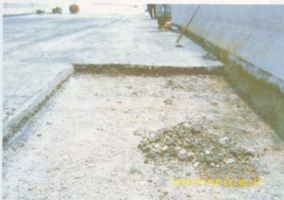
รูปที่ 35 การรื้อเพื่อซ่อมแซมโครงสร้างขึ้นทาง
