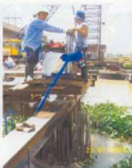
การเจาะคอนกรีตที่ปลายท่อเหล็ก สำหรับทำ Sonic Logging จนทะลุถึงชั้นดิน
