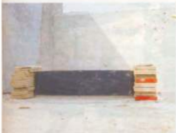
การติดตั้งแผ่นไม้สูงกว่าแผ่นยางประมาณ 1 ซม.
