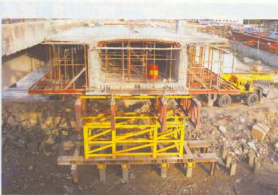
คานช่วงริมฝั่ง (End Span) ที่หล่อคอนกรีตแล้วเสร็จ
