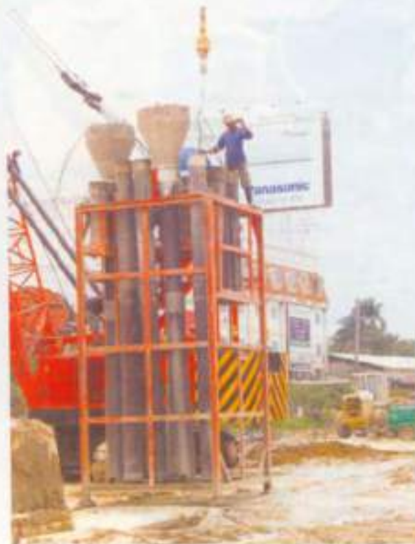
รูปที่ 10 ท่อสำหรับเทคอนกรีต (Tremie Pipe)
