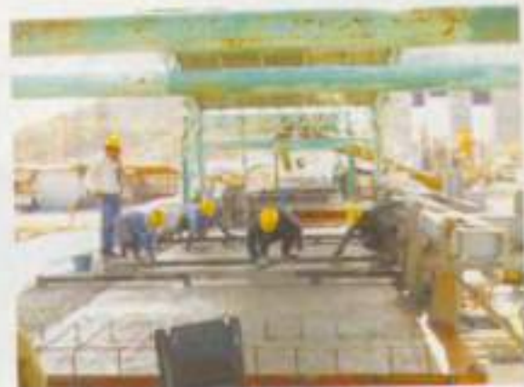
แต่งหน้าคอนกรีต
