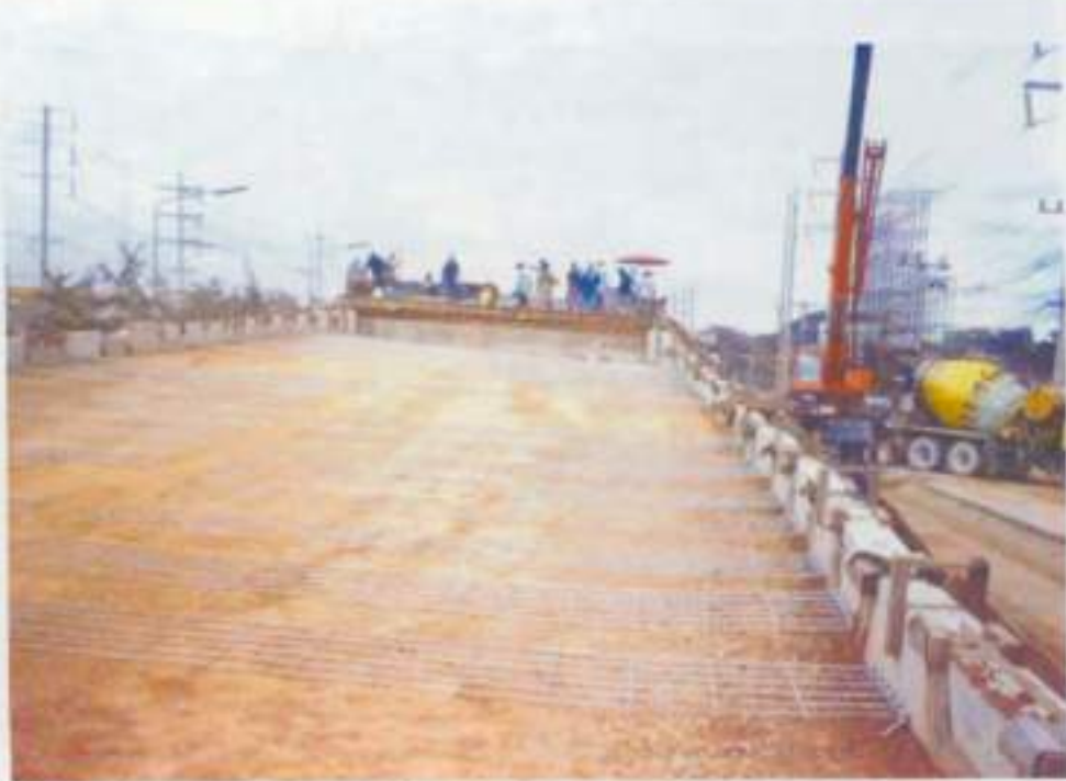
รูปที่ 28 การติดตั้งตะแกรงเหล็กในแต่ละชั้น ตามแบบก่อสร้าง
