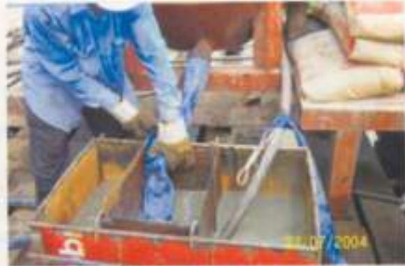
ปล่อยน้ำปูนลงในถัง Storage Tank แล้วทำการอัดน้ำปูน คอยตรวจสอบปริมาณน้ำปูนที่ถูกใช้ไป
