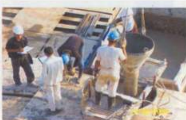
ต่อท่อ Tremie และกรวย สำหรับเทคอนกรีต
