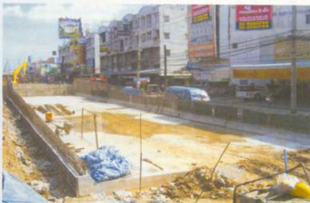
รูปที่ 7 Bearing Unit with Retaining Wall ขณะรอการประกอบแบบกำแพงด้านข้าง
