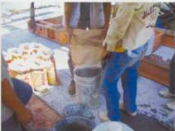
เตรียม High Strength Grout
