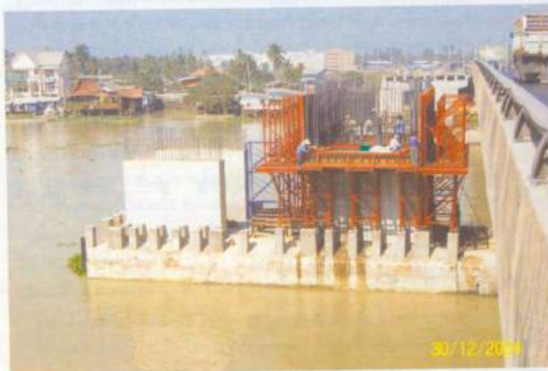
การผูกเหล็ก Bottom Slab ของ Pier Segment
