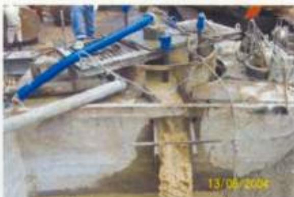
เปลี่ยนถ่ายสารละลายเบนโทไนท์ ระหว่างรอเทคอนกรีต
