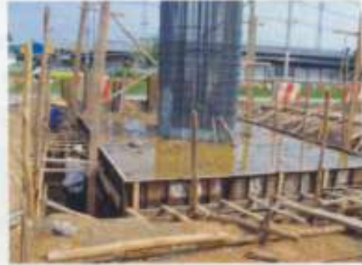
บ่มคอนกรีตฐานราก
