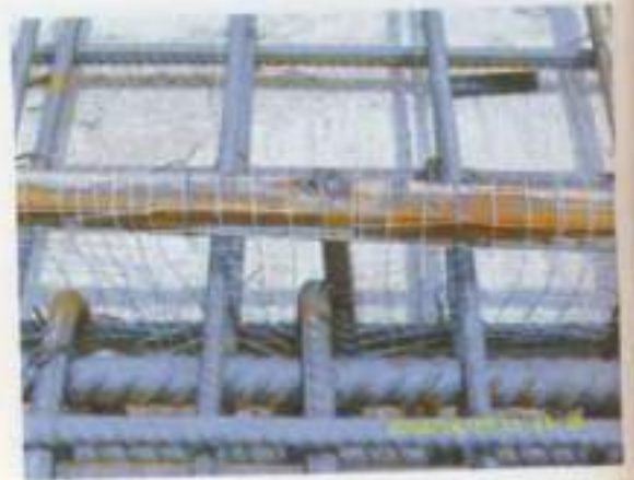
ติดตั้งตะแกรงกันคอนกรีต
