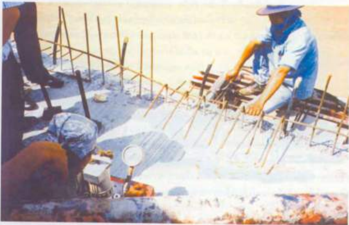
การติดตั้งลวดอัดแรงใน Transverse Tendon ด้วยแรงที่แบบกำหนด
