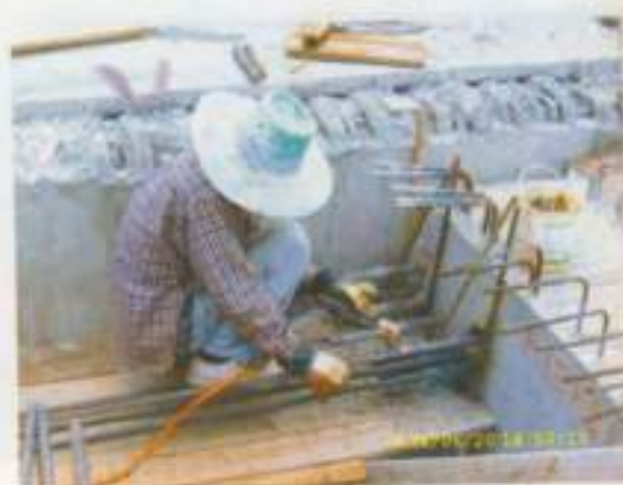
เสริมเหล็ก End Diaphragm
