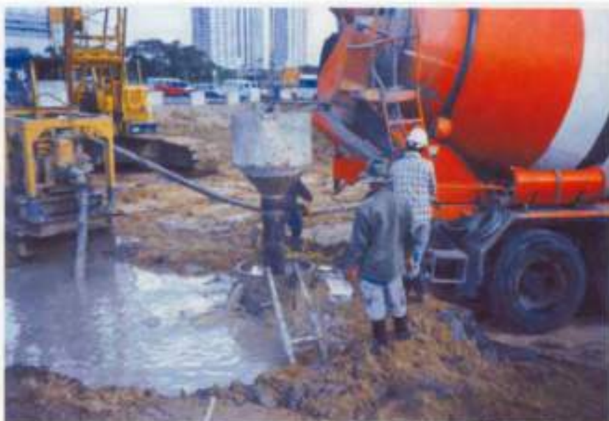
ใช้ท่อ Tremie ในการเทคอนกรีตจากกันหลุมขึ้นมา
