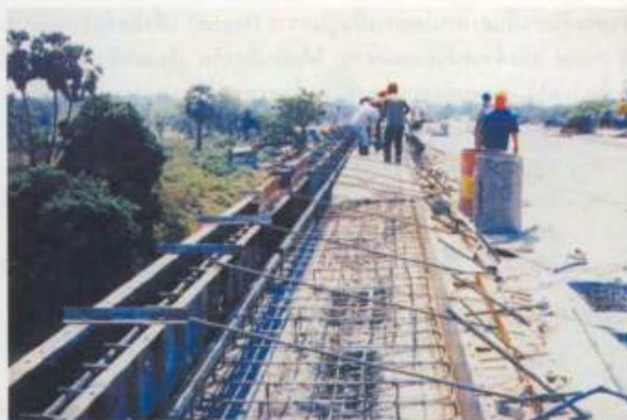
รูปที่ 5 แสดงการเทคอนกรีตทางเท้าและราวสะพาน
