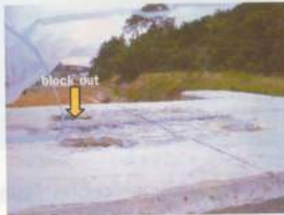
สกัดผิวหน้าคอนกรีตของ Pier Column
