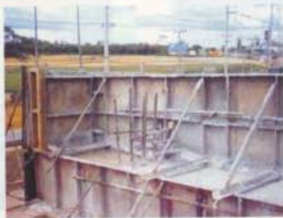
เหล็กเสริม Seismic Buffer ใน Crosshead
