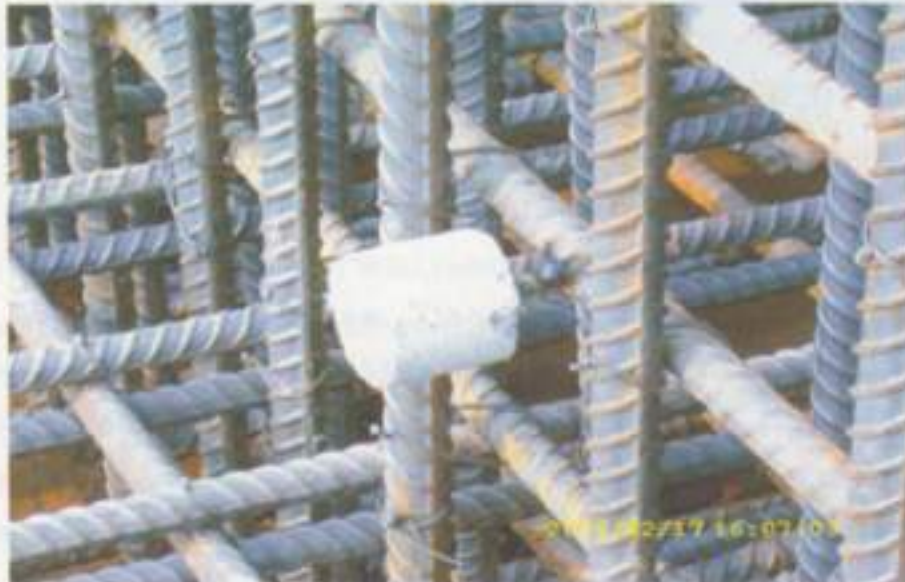
รูปที่ 3 การตรวจระยะคานกรัดหุ้มเหล็กเสริม (Covering)
