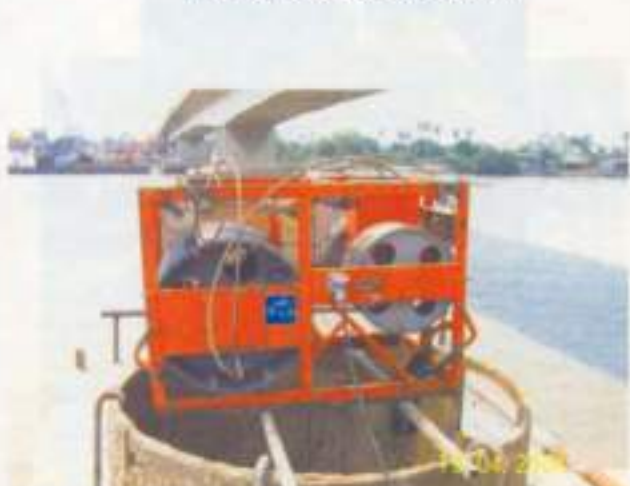
การตรวจสอบสภาพหลุมเจาะ (Drilling monitor) โดยใช้เครื่องมือ KODEN
