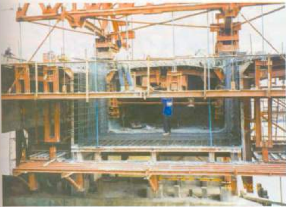
มุกเหล็กเสริมในพื้นที่ล่าง (Bottom Slab) และกำแพง (Wall) ของ Segment
