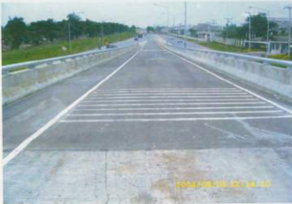
รูปที่ 31 การก่อสร้างผิวทางลาดยาง บนโครงสร้างกำแพงกันดิน
