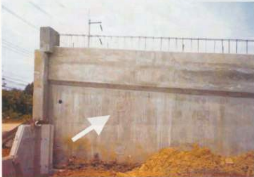
รูปที่ 25 การติดตั้งแผ่นใยสังเคราะห์ ปิดรูระบายน้ำของผนัง Abutment
