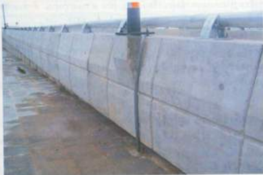
ขอบทางแบบ Precast Fin เมื่อแล้วเสร็จ
