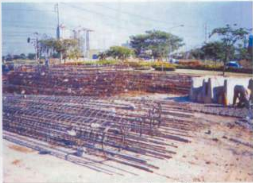
เหล็กเสริมเสาเข็มเจาะที่ผูกเตรียมไว้
