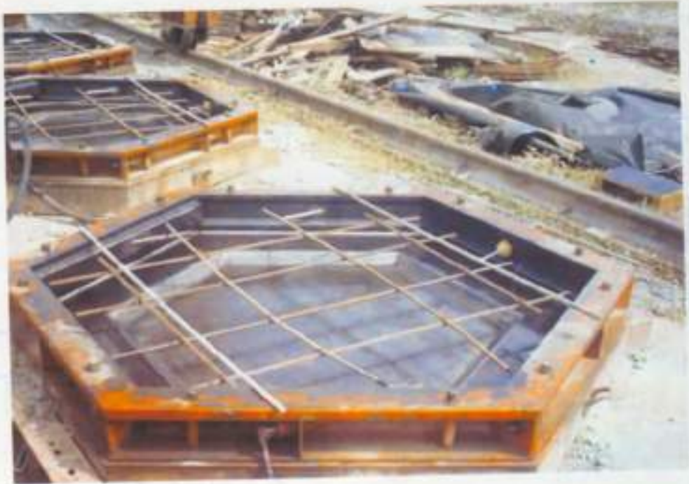
รูปที่ 8 แบบหล่อแผ่นผนังคอนกรีตตามที่กำหนดในแบบก่อสร้างในสนาม
