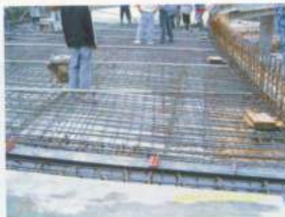
การติดตั้งเหล็กยกระดับในทางโค้ง
