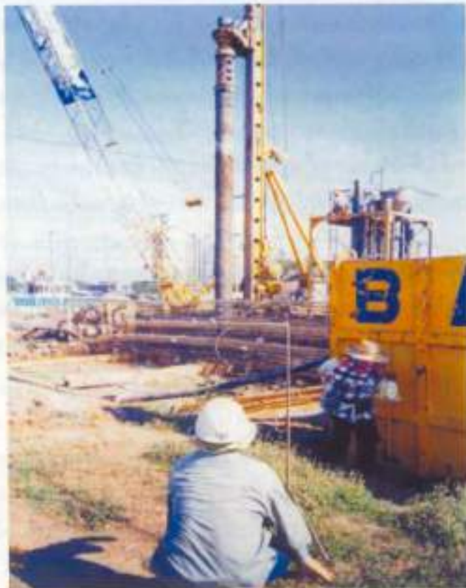
ตรวจสอบแนวตั้งของปลอกเหล็ก (Steel Casing)
