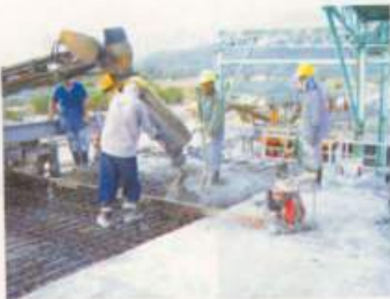
เท Deck Slab
