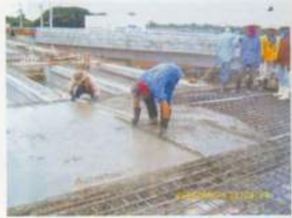
ตักแต่งผิวหน้าคอนกรีต
