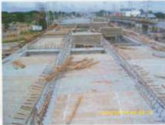
ปูแบบ Precast Concrete Slab
