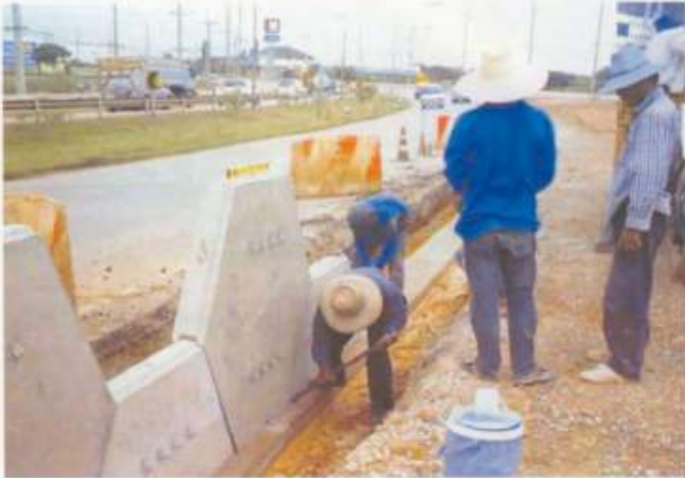
รูปที่ 17 การปรับแผ่นผนังคอนกรีตให้ได้ แนว ระนาบ และแนวตั้ง
