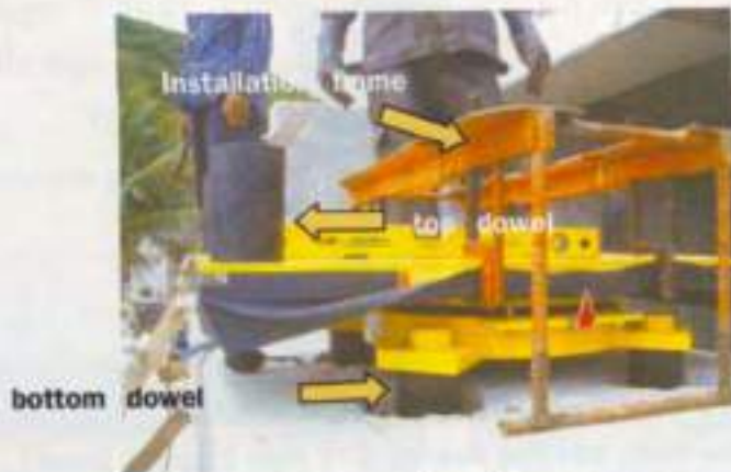
ยก Pot Bearing ขึ้นติดตั้งบน Pier Column
