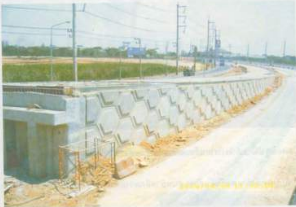
รูปที่ 32 การก่อสร้างผิวทางคอนกรีต บนโครงสร้างกำแพงกันดิน
