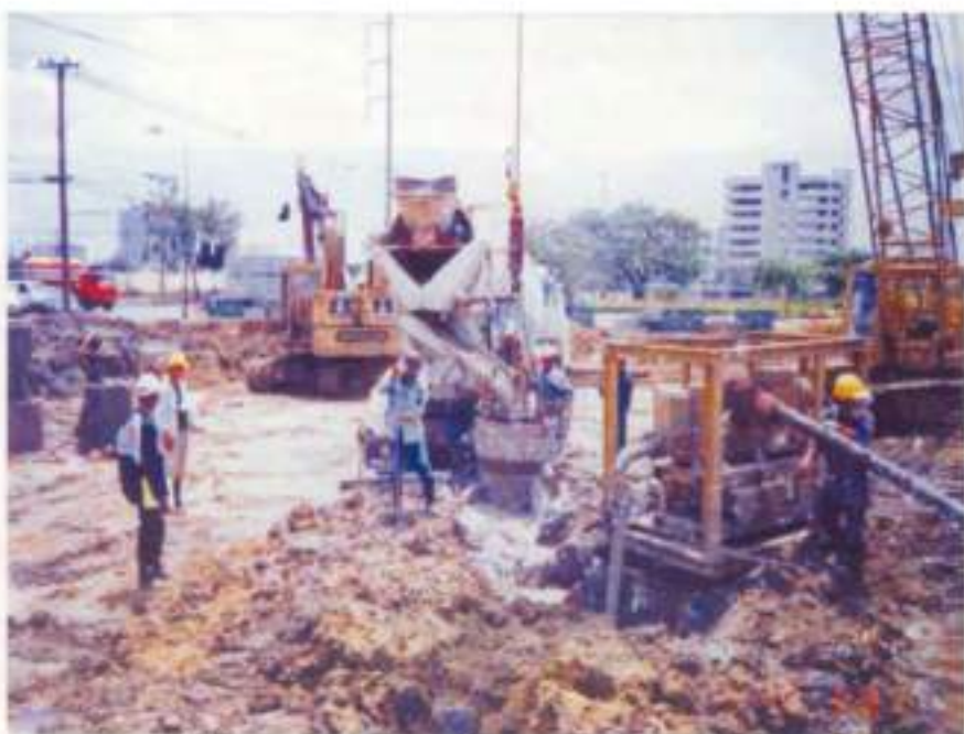
ขณะทำการเทคอนกรีต น้ำยา Bentonite จะส้นออกมา และใช้ Pump ดูดกลับมา Recycle ใช้ได้ใหม่
