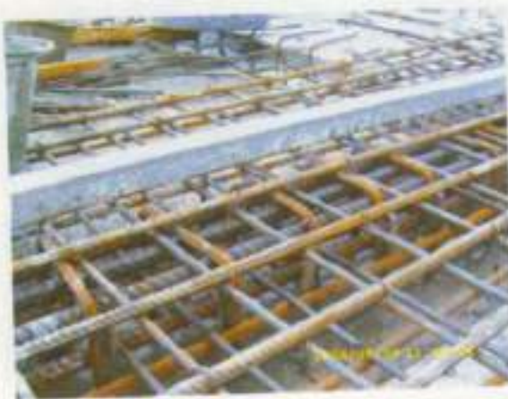
ติดตั้งเหล็กฉากจุดที่หยุดเทคอนกรีต
