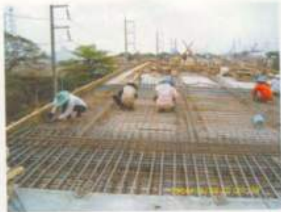
เสริมเหล็กล่าง และที่ Crosshead
