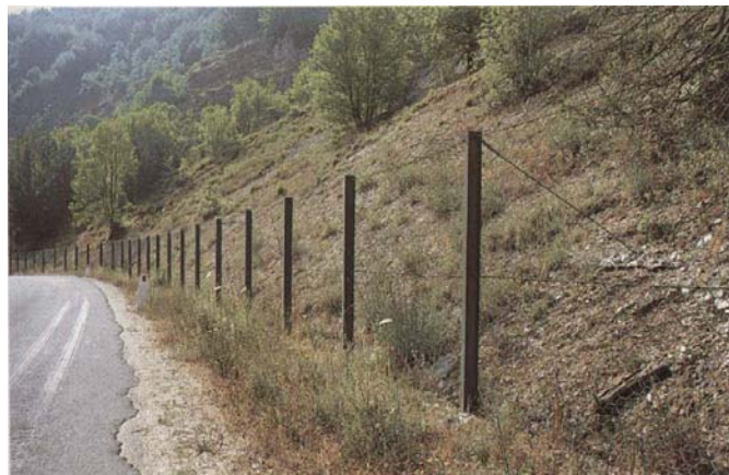
รูปที่ 4.3-35 แสดงระบบตาข่ายป้องกันหินร่วงสำหรับช่วงที่มีเขตทางแคบ [9]
