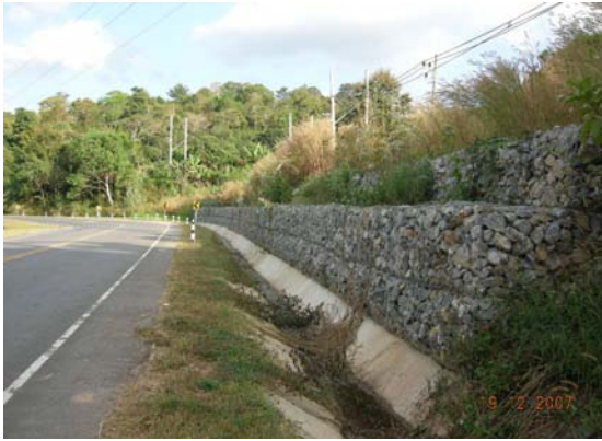
รูปที่ 4.3-17 Gabion Wall ป้องกันการเคลื่อนตัวด้านลาดเหนือคันทาง
