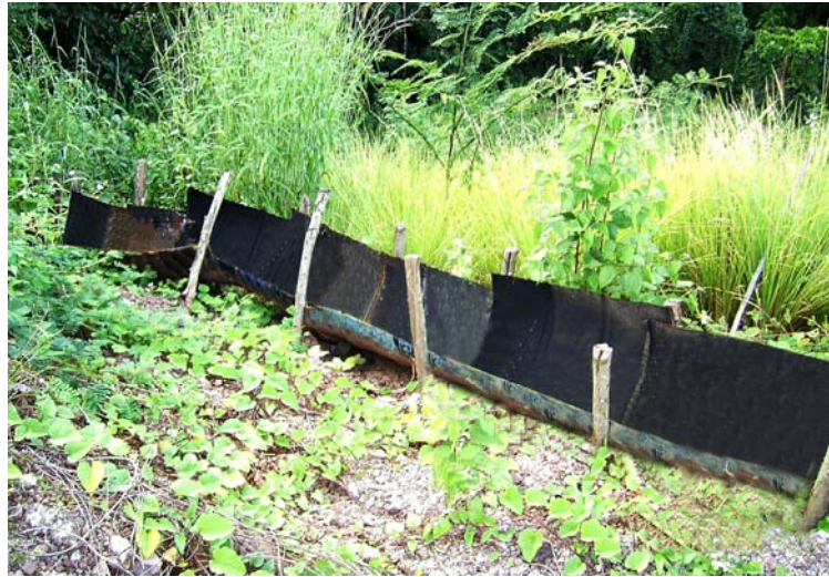
(ข) การใช้ถังขนาด 200 ลิตร ฝาครึ่งเป็นรางระบายน้ำชั่วคราว
