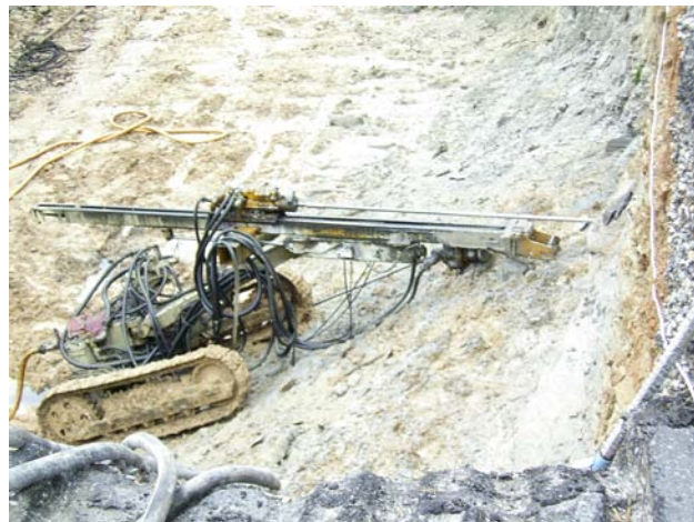
(ข) เครื่องจักรที่ใช้ในการก่อสร้าง Soil Nailing
