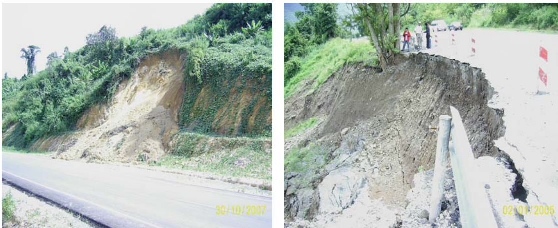
รูปที่ 3.3-13 ลักษณะความเสียหายเนื่องจากอิทธิพลของน้ำ และ/หรือ การขาดเสถียรภาพ ของเชิงลาด
