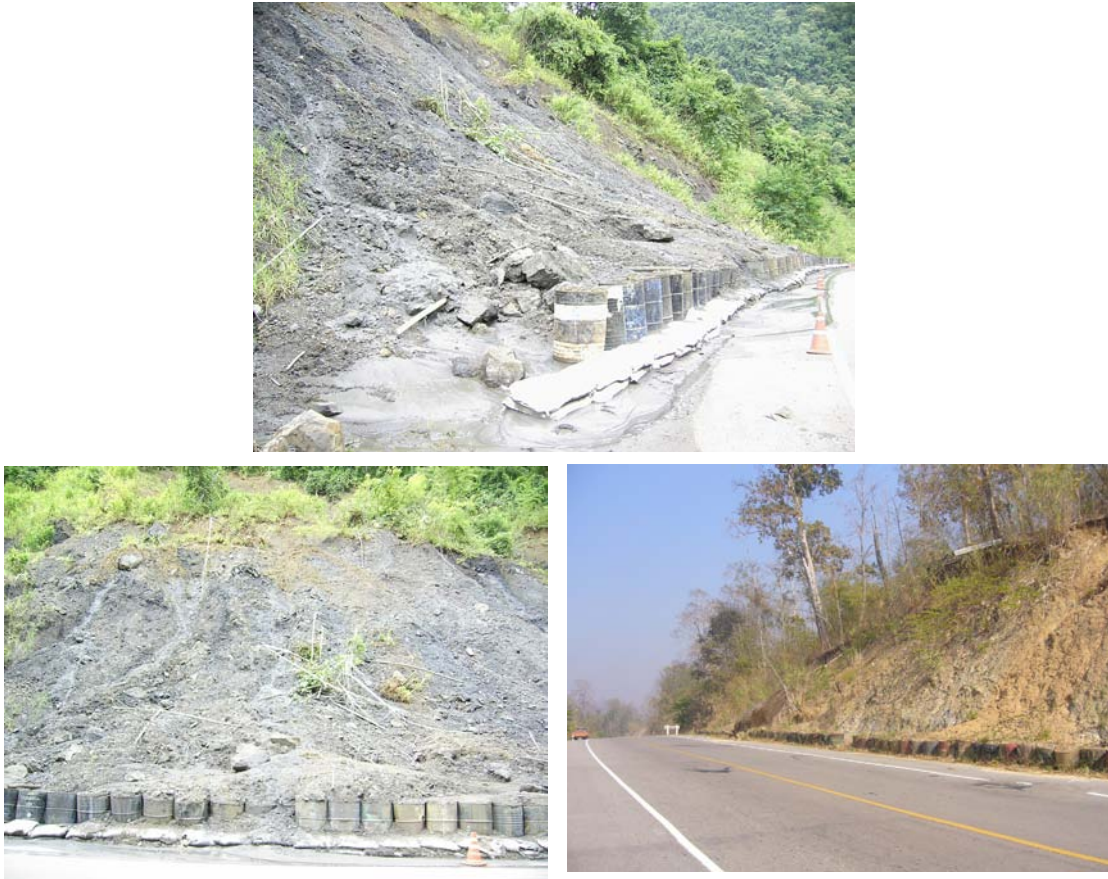
รูปที่ 3.3-15 การประยุกต์ใช้ถังขนาด 200 ลิตร ป้องกันความเสียหายบริเวณเชิงลาด
