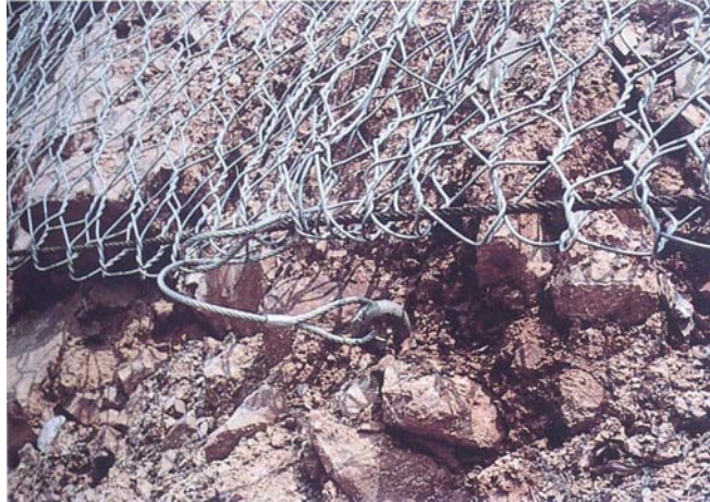
รูปที่ 4.3-27 แสดงแบบ ส่วนล่างของตาข่ายที่เปิดออกได้ [9]
