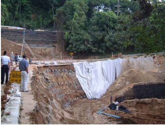
(ก) การก่อสร้าง Soil Nailing บริเวณลาดคันทาง
