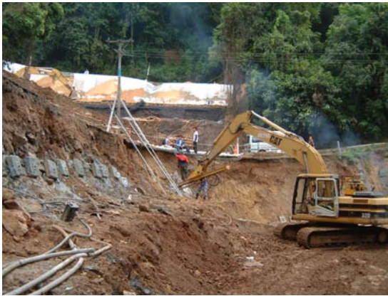
(ก) การก่อสร้าง Soil Nailing บริเวณลาดคันทาง
