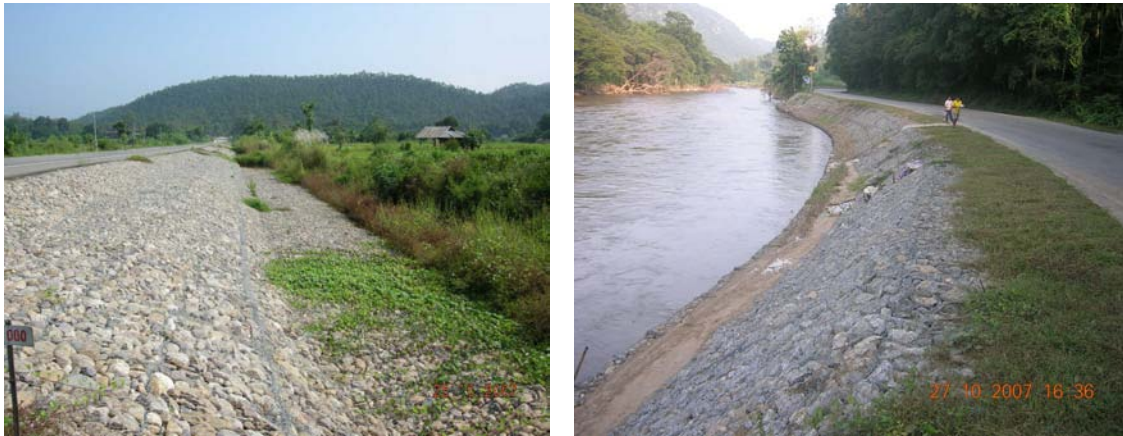
รูปที่ 4.3-4 การประยุกต์ใช้ Mattress บริเวณเชิงลาดและริมน้ำ
