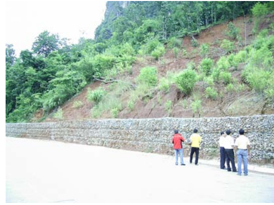
รูปที่ 4.3-17 Gabion Wall ป้องกันการเคลื่อนตัวด้านลาดเหนือคันทาง
