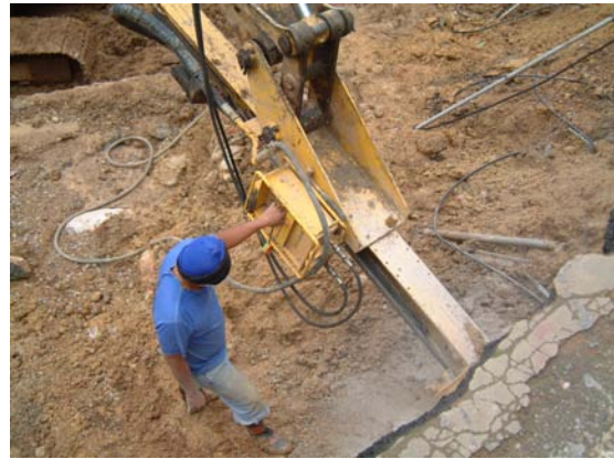
(ก) การก่อสร้าง Soil Nailing บริเวณลาดคันทาง
