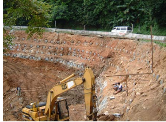
(ก) การก่อสร้าง Soil Nailing บริเวณลาดคันทาง
