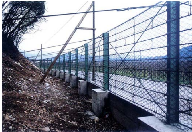
รูปที่ 4.3-34 แสดงรายละเอียด Rock Fall Catch Fence ประกอบด้วย Steel Post, Netting และ Tension wire [9]
