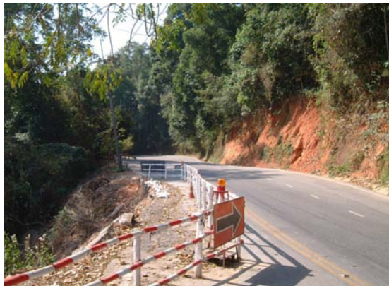
(ค) ติดตั้งป้ายเตือนและป้ายบังคับการจราจร
