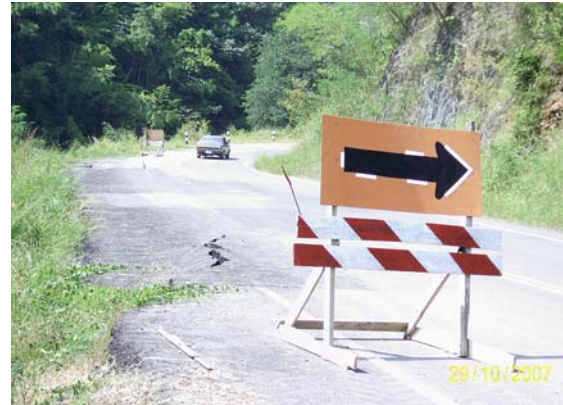
(ค) ติดตั้งป้ายเตือนและป้ายบังคับการจราจร
