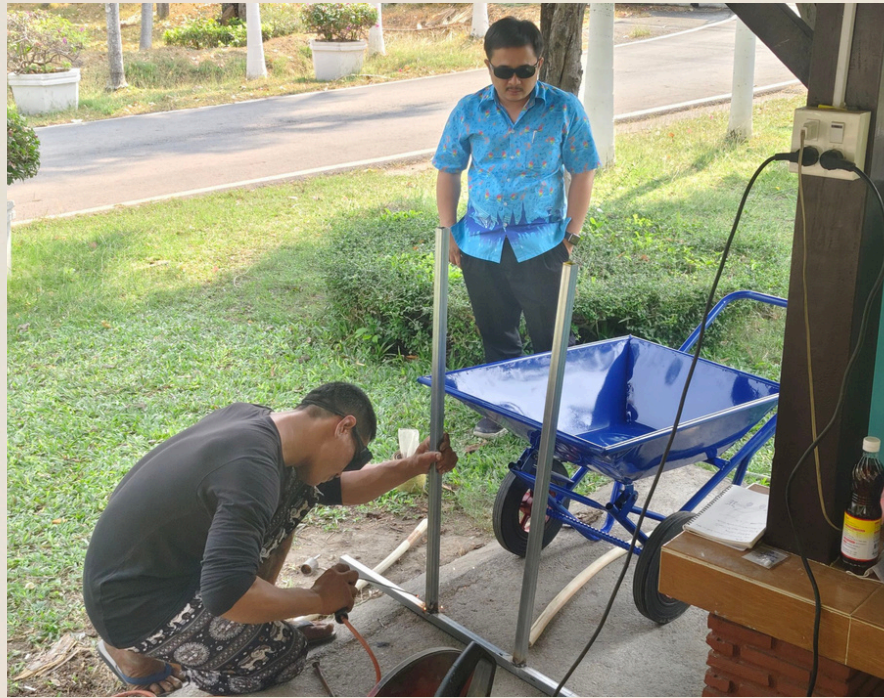
1. นำเหล็กกล่องขนาด 1x1 นิ้วมาวัดขนาดกับรถเข็นที่จัดเตรียมไว้ เมื่อได้ขนาดที่ต้องการทำการเชื่อมโครงเหล็ก
