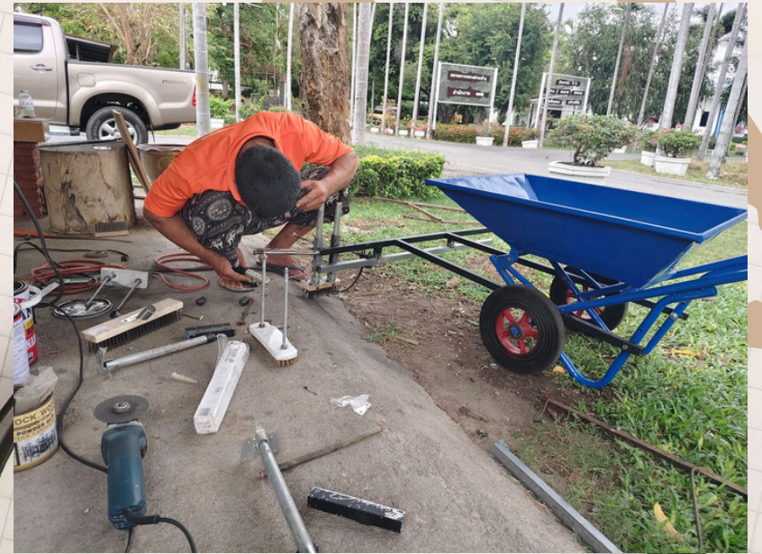
2. วัดระยะของตำแหน่งติดตั้งชุดแปรงลวดและที่บังฝุ่นแล้วทำการเจาะและเชื่อมเหล็กเพื่อติดตั้ง
