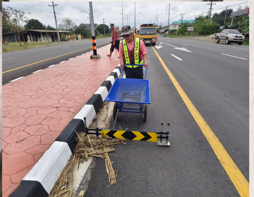
5. นำอุปกรณ์มาประกอบและทดลองใช้งาน
