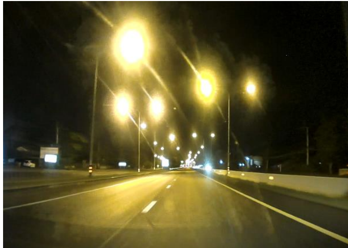
ภาพตัวอย่างช่วงถนนที่ติดตั้งไฟส่องสว่างถนน
