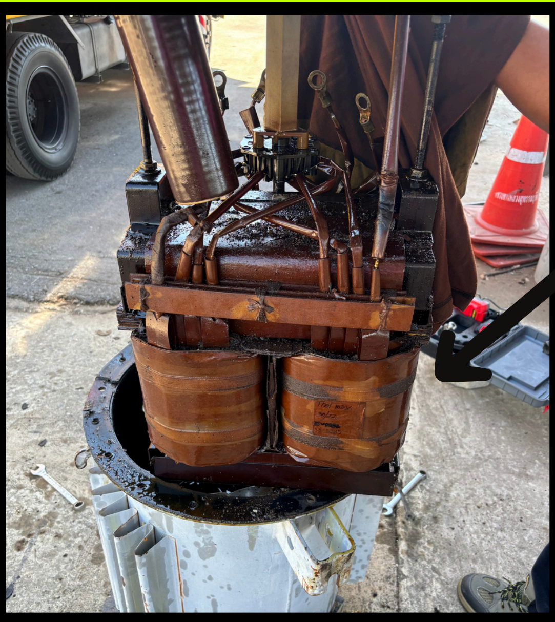
หม้อแปลงระบบ1เฟส
