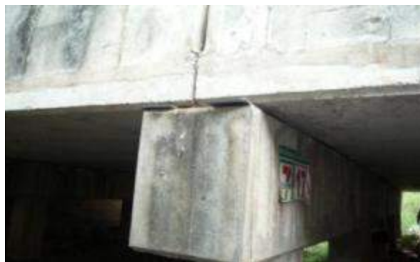
รูปที่ 4-63 การเคลื่อนหลุดระหว่างแผ่นยางรองคอสสะพาน
