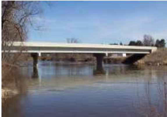
รูปที่ 3-18 สะพานเดี่ยว
