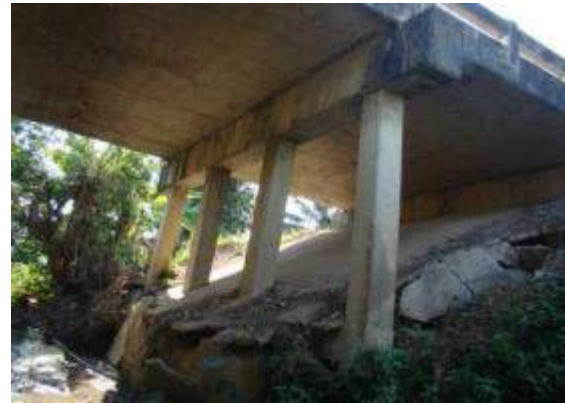
รูปที่ 4-97 มีการกัดเซาะจากน้ำ
