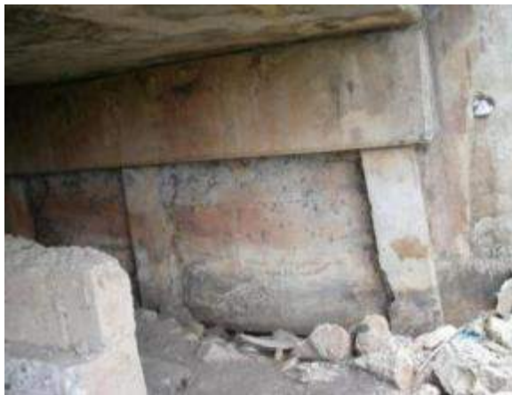
รูปที่ 4-93 สภาพของตอม่อและกำแพงกันดิน
