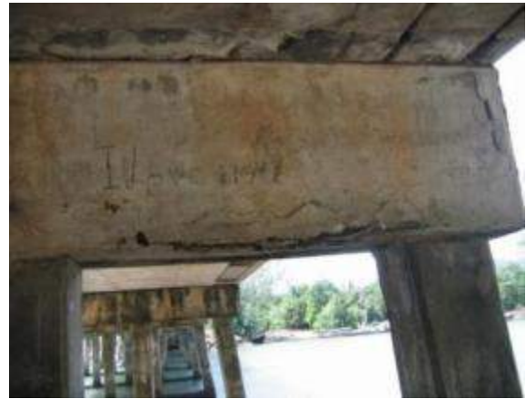
รูปที่ 4-28 สภาพการแตกร้าวของคานรัดหัวเสา
