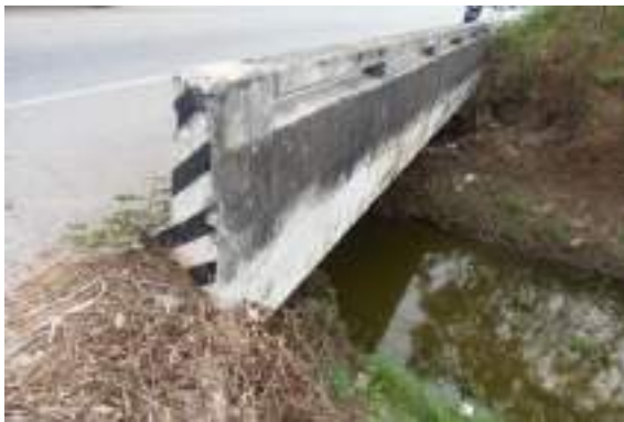
รูปที่ 5-20 ราวสะพานด้านซ้าย (3-สภาพพอใช้)
