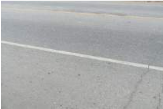
รูปที่ 5-16 ผิวทางเชิงลาด (4-สภาพดีพอใช้)
