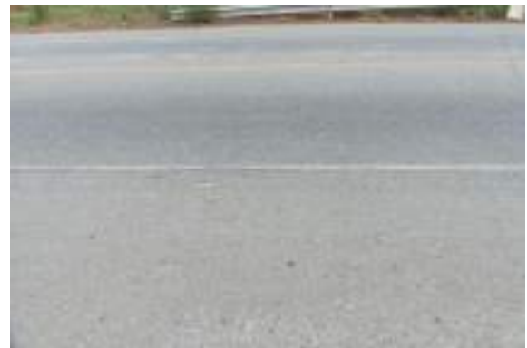
รูปที่ 5-19 ผิวทางเชิงลาด (4-สภาพดีพอใช้)
