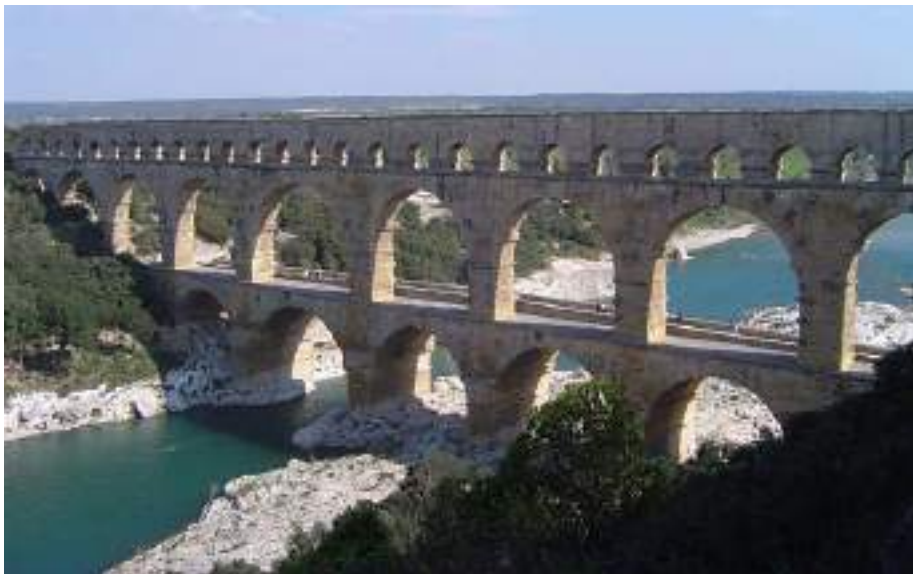
รูปที่ 1-6 สะพาน Pont Du Gard
