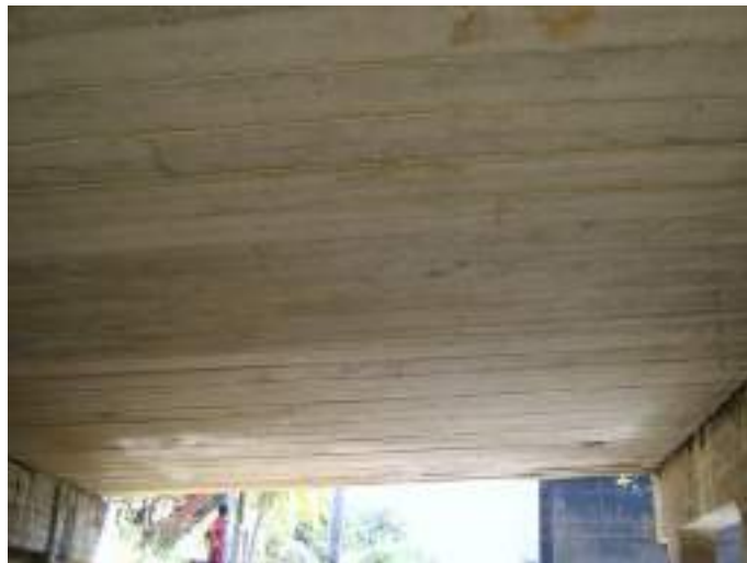
รูปที่ 2-5 สะพานแบบคานคอนกรีตวางประชิด (Multi-Beam)
