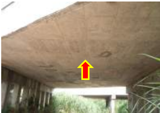
รูปที่ 2-10 พื้นสะพาน
