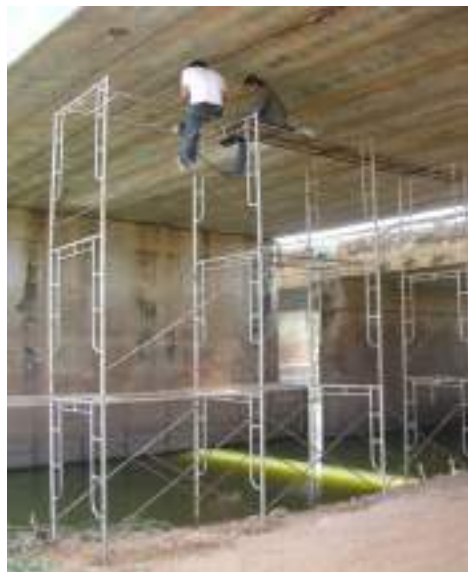
รูปที่ 3-12 แสดงการตรวจสอบสะพานโดยการใช้นั่งร้าน
