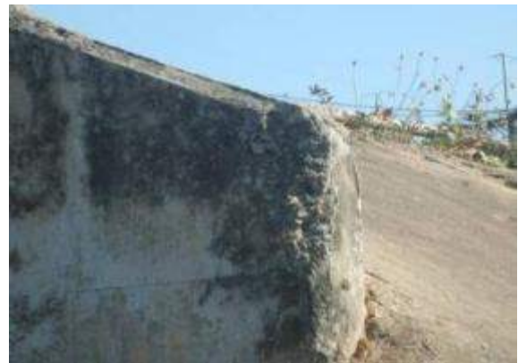
รูปที่ 4-57 มีการหลุดเซาะ
