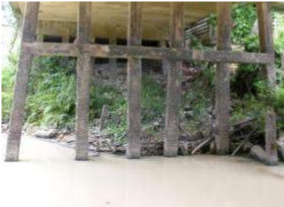
รูปที่ 4-42 การกีดกร่อนและการทับถมของเศษอิฐที่ตอม่อกลางน้ำ
