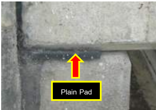
รูปที่ 2-24 แผ่นรองรับคานแบบ Plain Pad
