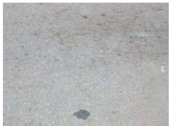
รูปที่ 4-79 ลักษณะการสึกกร่อนของผิวถนนจนเห็นเม็ดหินเกิดขึ้นทั่วสะพาน
