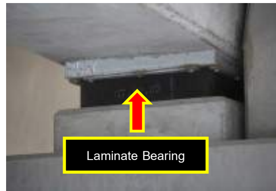
รูปที่ 2-25 แผ่นรองรับคานแบบ Laminate
