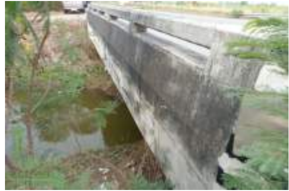
รูปที่ 5-11 ราวสะพานด้านซ้าย (3-สภาพพอใช้)
