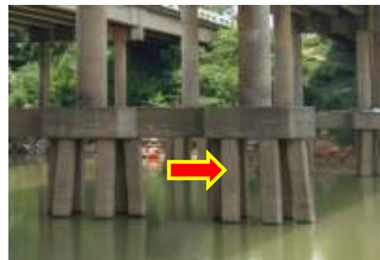
รูปที่ 2-21 เสาเข็ม
