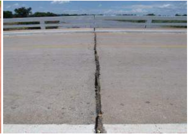
รูปที่ 4-72 สภาพรอยต่อระหว่างสะพาน
