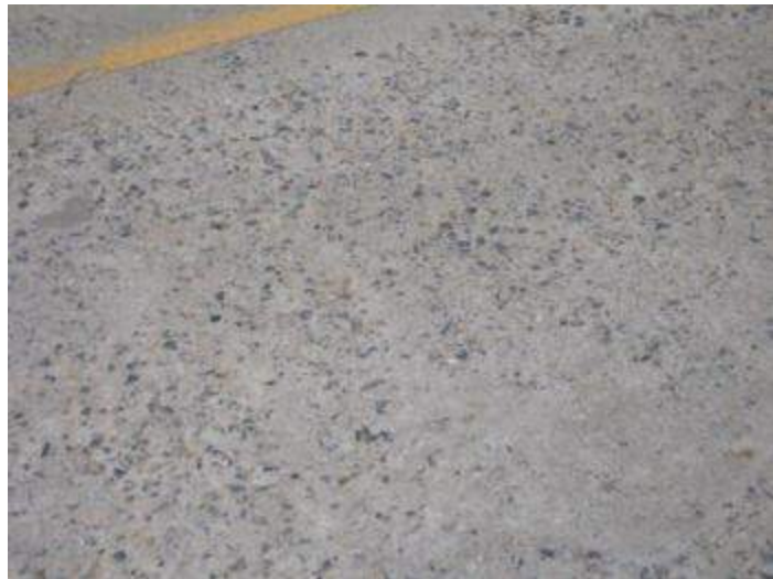
รูปที่ 4-7 การสึกหรอของผิวคอนกรีต
