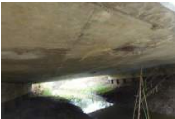
รูปที่ 5-30 แผ่นพื้น (4-สภาพดีพอใช้)
