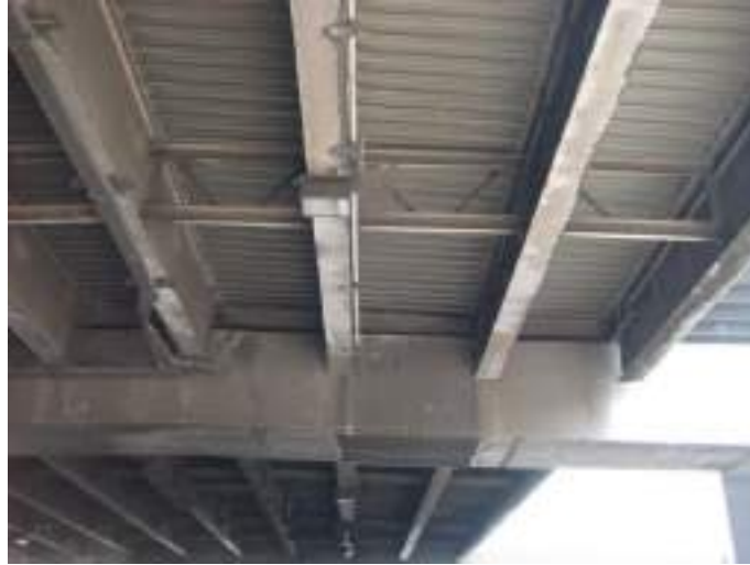
รูปที่ 2-7 สะพานแบบคานคานเหล็กรูปตัวไอ (Steel I-Girder)
