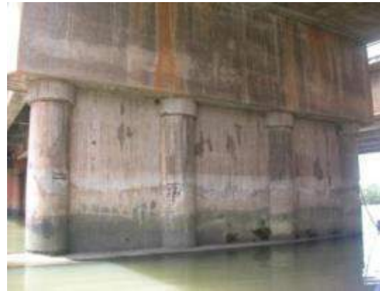
รูปที่ 4-43 แสดงความเสียหายตอม่อกลางน้ำ
