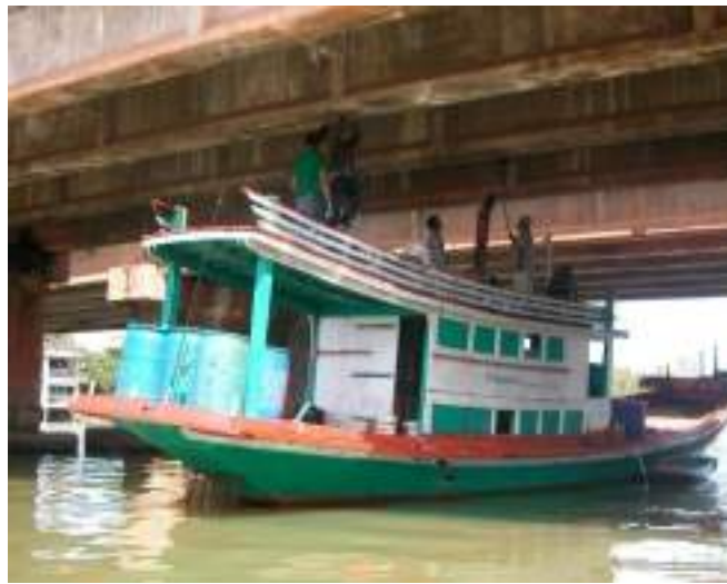
รูปที่ 3-13 แสดงการตรวจสอบโครงสร้างสะพานโดยการไต่เรือ
