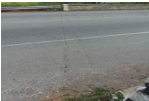
รูปที่ 5-18 รอยต่อเผื่อการขยายตัว (3-สภาพพอใช้)
