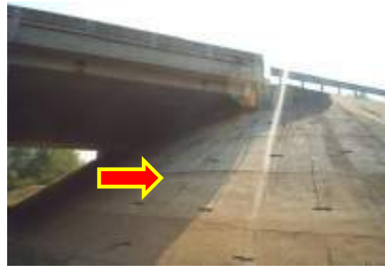
รูปที่ 2-37 ลาดป้องกันตลิ่ง
