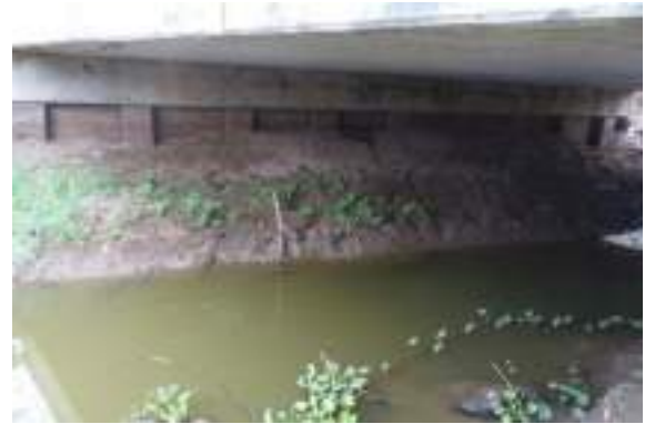
รูปที่ 5-29 กำแพงกันดิน (3-สภาพพอใช้)
