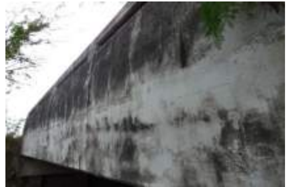
รูปที่ 5-33 ราวสะพานด้านซ้าย (3-สภาพพอใช้)
