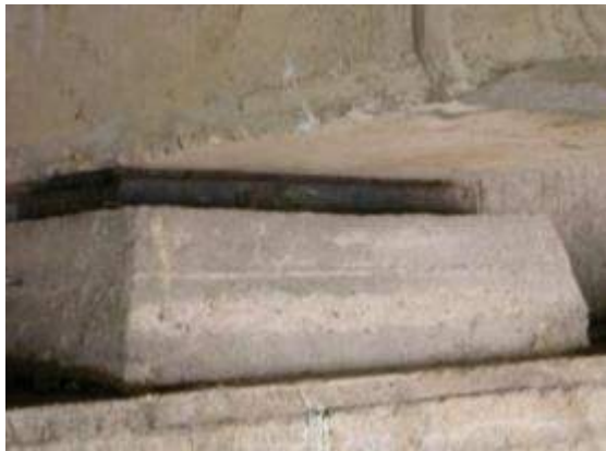
รูปที่ 4-68 รูปแสดงสภาพของแผ่นรองรับคาน
