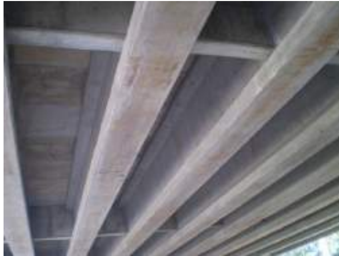
รูปที่ 2-2 สะพานแบบคานคอนกรีตอัดแรงรูปตัวไอ (I-Girder)
