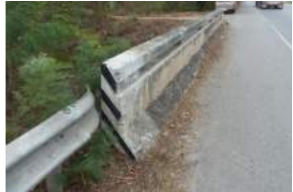
รูปที่ 5-17 ราวสะพานด้านซ้าย (3-สภาพพอใช้)
