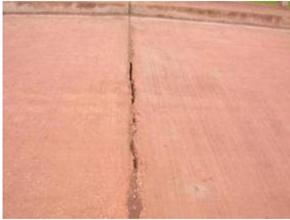
รูปที่ 4-71 รอยต่อเพื่อการขยายตัวมีเศษดินอุดตันทำให้พฤติกรรมไม่เป็นไปตามที่ได้ออกแบบ
