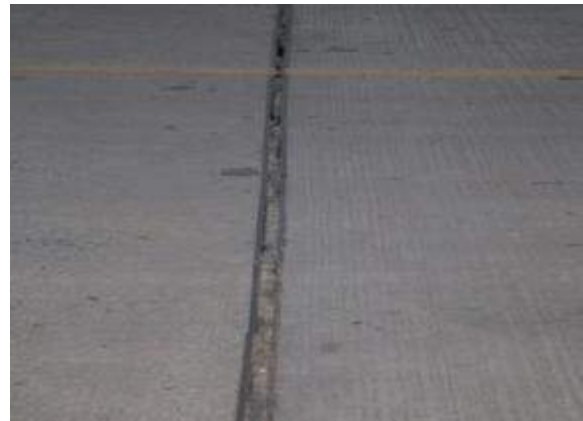
รูปที่ 4-74 สภาพรอยต่อเพื่อการขยายตัวของสะพาน
