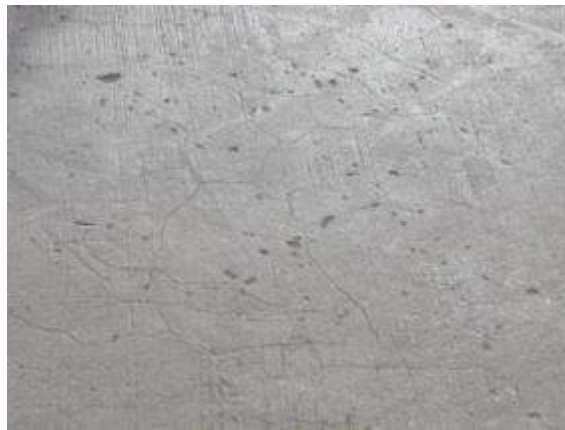
รูปที่ 4-80 รูปแสดงรอยแตกแบบจระเข้และความขรุขระของผิวทาง
