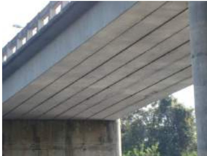
รูปที่ 2-4 สะพานแบบคอนกรีตอัดแรงรูปกล่อง (Box Girder)
