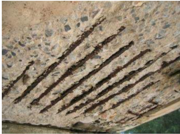
รูปที่ 4-11 การเกิดสนิมในเหล็กเสริม
