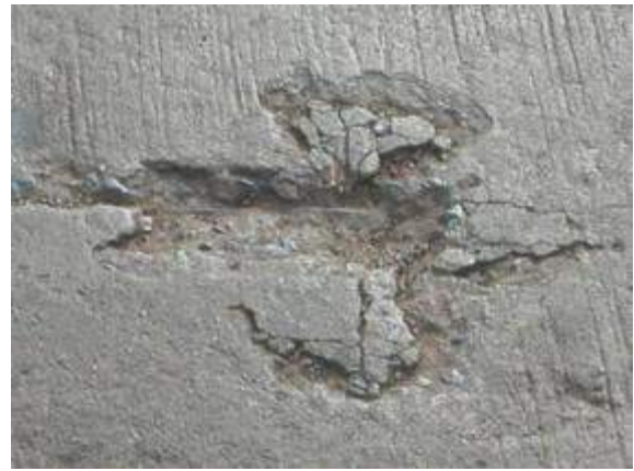
รูปที่ 4-77 การเป็นหลุมจนเห็นเหล็กเสริมของผิวทาง
