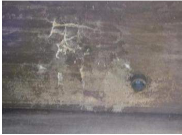
รูปที่ 4-5 การเกิดคราบเกลือตามแนวการไหลของน้ำ
