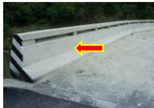
รูปที่ 2-33 ราวสะพาน
